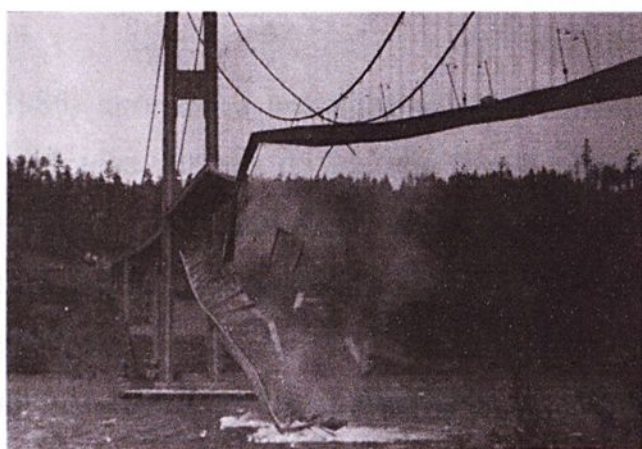
FIGURA 1.2 – O movimento torcional violento persistiu por volta de 45 minutos até ao colapso da ponte Tacoma Narrows.
