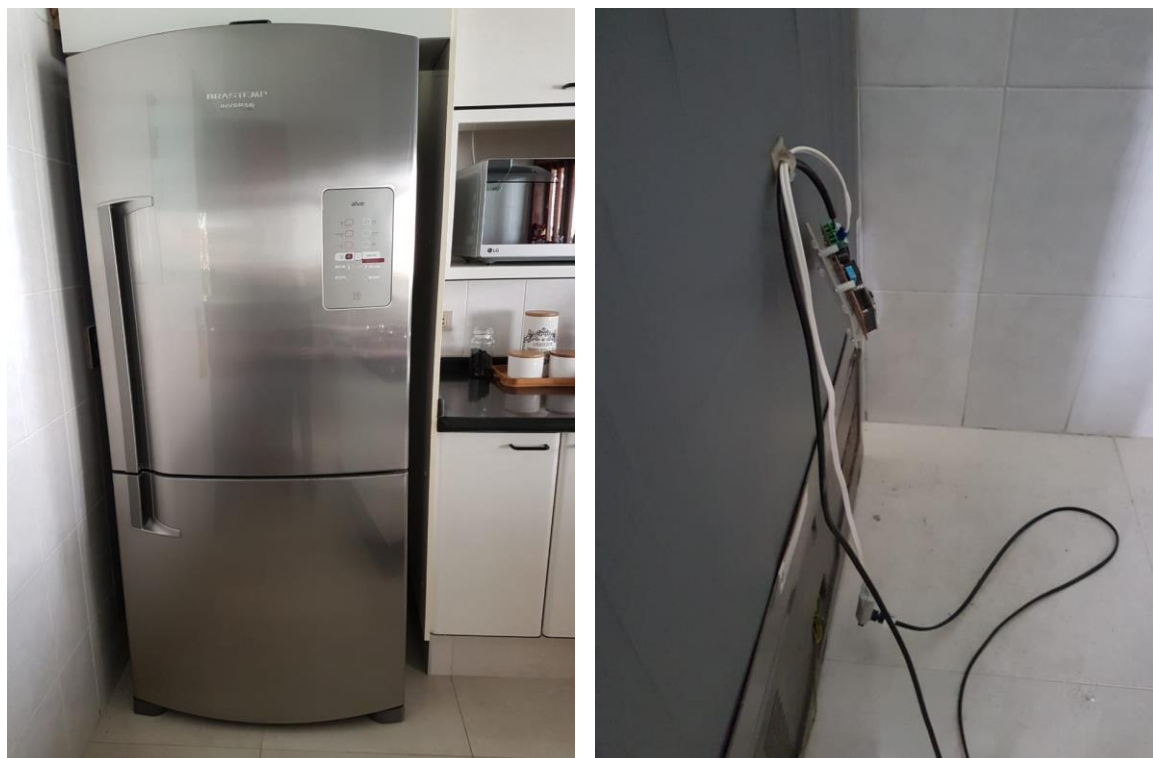
Figura 45 – Instalação do Endpoint001
