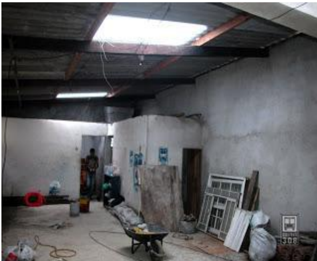
Figura 38 – Reforma do madeiramento do telhado que foi feito. Coletivo Ateliê 308, 2009. Fonte: Arquivo pessoal.
