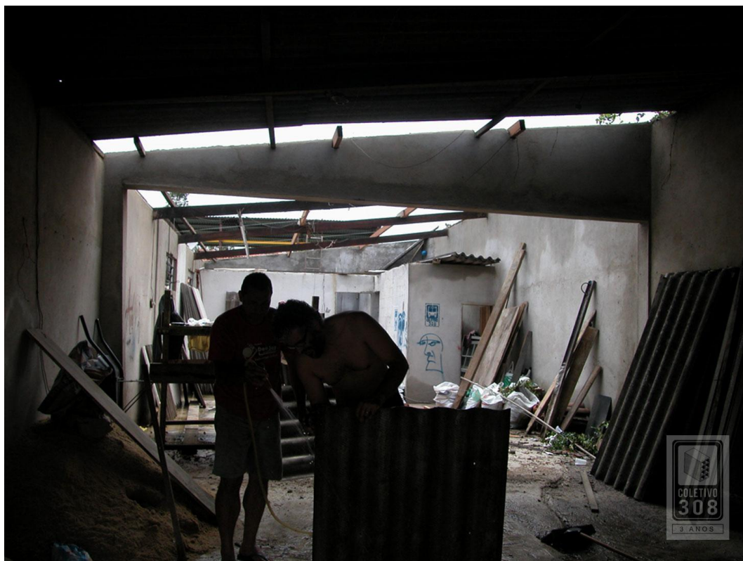
Figura 30 – Início da reforma do ateliê do grupo Coletivo Ateliê 308, em 2009: Desmonte do telhado antigo; tratamento das tesouras infestadas de cupim e retirada do entulho encontrado no espaço.
