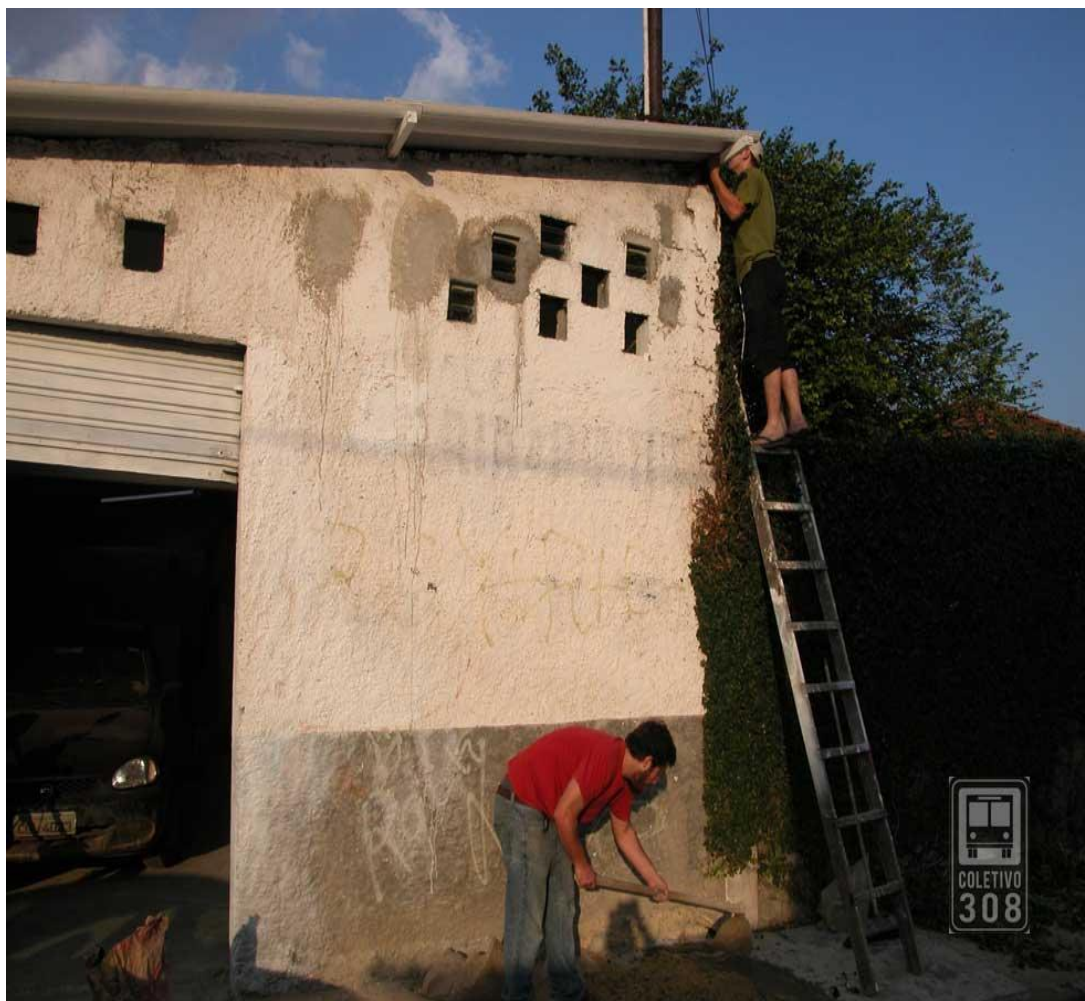
Figura 37 – Fachada do ateliê: César Riello preparando massa e Rodrigo Kenichi fazendo reparos no telhado. Coletivo Ateliê 308, 2009. Fonte: Arquivo pessoal.
