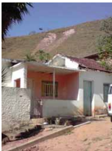
Figura 16 - Vista parcial da Rua José Crispim Filho, localizada no Bairro São Roque/Aroeira. Observam-se as ausências de pavimentação e calçada. Coordenadas do local da imagem: 22^{\circ} 49,990' S / 45^{\circ} 12,794' W . Data da registro da imagem: 01/09/ 2010.
