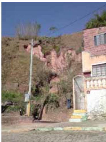
Figura 17 - Vista parcial da porção final da Rua José Marcelino Loyola, localizada no Bairro São Roque/Aroeira. Observa-se a ocorrência de intenso processo erosivo na encosta adjacente à edificação. Coordenadas do local da imagem: 22° 50,098' S / 45° 13,065' W. Data de registro da imagem: 01/09/2010.
