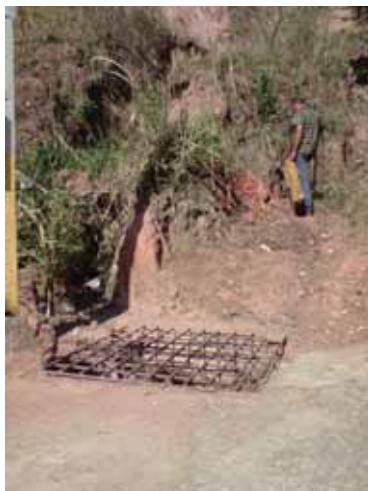
Figura 18 - Vista parcial da porção final da Rua José Marcelino Loyola, localizada no Bairro São Roque/Aroeira. Observa-se a existência de ponto de captação de águas pluviais, localizado no pé da encosta. Coordenadas do local da imagem: 22° 50,098' S / 45° 13,065' W. Data de registro da imagem: 01/09/2010.
