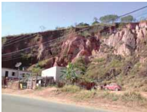
Figura 24 - Vista parcial da encosta com erosões intensas. Observa-se a proximidade das edificações sujeitas a soterramento por escorregamento de solo. Coordenadas do local da imagem: 22°51,606' S / 45°13,555' W. Data de registro da imagem: 01/09/2010.
