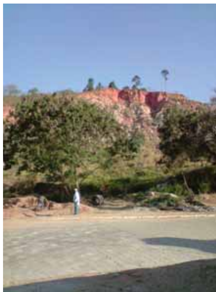
Figura 28 - Vista parcial da encosta localizada nas proximidades da Basílica Nacional de Nossa Senhora Aparecida. Observa-se a existência de intenso processo erosivo e a característica siltosa do solo presente no local. Coordenadas do local da imagem: 22° 51,541' S / 45° 14,772' W. Data de registro da imagem: 01/09/2010.
