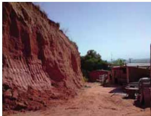
Figura 13 - Escavação de encosta para construção de edificação. Observa-se a característica siltosa do solo escavado. Coordenadas do local da imagem: 22° 49,871' S / 45°12,742' W. Data da registro da imagem: 01/09/2010.
