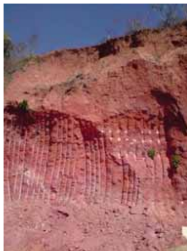
Figura 14 - Escavação de encosta para construção de edificação. Observa-se a espessura acentuada do horizonte pedológico C, constituído de solo com característica siltosa. Coordenadas do local da imagem: 22° 49,871' S / 45°12,742' W. Data da registro da imagem: 01/09/2010.
