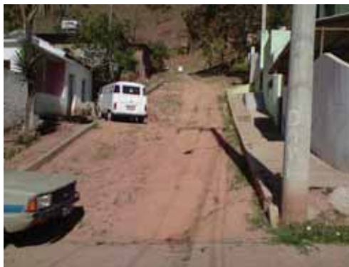
Figura 15 - Vista geral da Rua José Crispim Filho, localizada no Bairro São Roque/Aroeira. Observam-se as ausências de pavimentação, sistema de drenagem superficial e a característica siltosa do solo local. Coordenadas do local da imagem: 22^{\circ} 49,990' S / 45^{\circ} 12,794' W . Data de registro da imagem: 01/09/2010.
