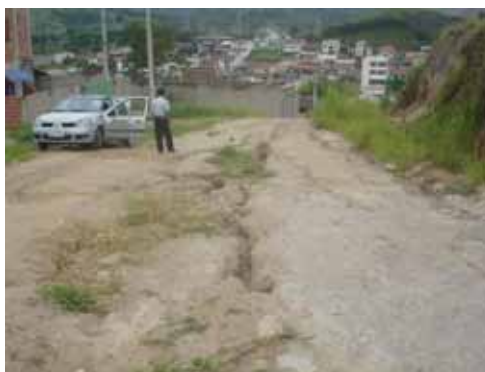
Figura 30 - Vista parcial da Rua Itapetininga no bairro Itaguaçu. Observa-se a existência de alta declividade. Coordenadas do local da imagem: 22° 51,897' S / 45° 15,523' W. Data de registro da imagem: 14/02/2011.
