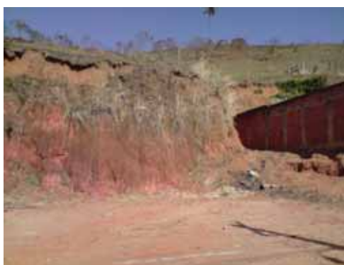
Figura 19 - Vista parcial de terreno preparado para a construção de novas edificações, localizado na Rua Zequinha Lemes, do Bairro São Roque/Aroeira. Observa-se a presença de talude vertical executado na encosta. Coordenadas do local da imagem: 22° 50,117' S / 45° 13,127' W. Data de registro da imagem: 01/09/2010.
