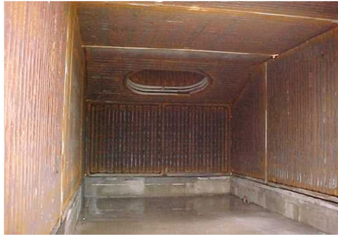
Figura 2.16: Vista dos tubos internos utilizados para resfriamento da câmara de combustão.
