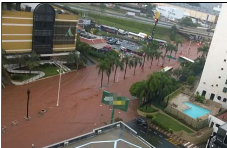
Figura 9 – Avenida Alberto Andaló alagada no ano de 2015.
