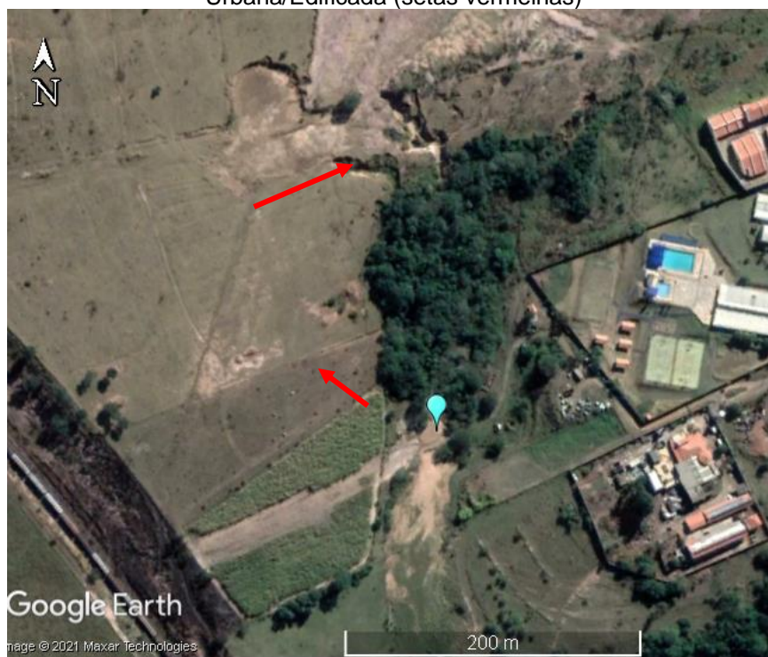
Figura 33: Nascente (ponto azul) com faixa de APP menor que os limites estabelecidos pela legislação, processos erosivos de ravinamento nos limites das zonas Agropecuária e Área Urbana/Edificada (setas vermelhas)
