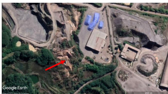
Figura 23: Processos erosivos de ravinamento identificado na zona Área das Cavas e Área de Operações (seta vermelha)
