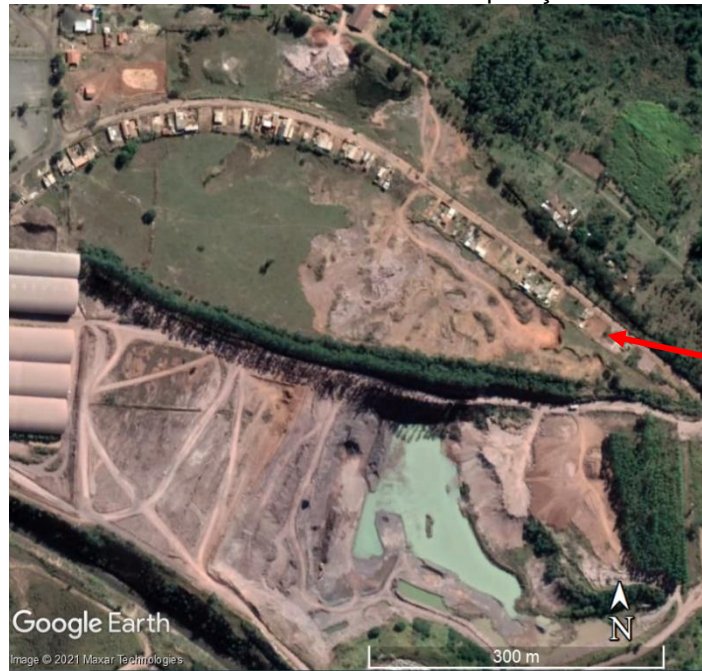
Figura 28: Ausência de cobertura vegetal e processo erosivos de ravinamento (seta vermelha) identificado na zona área de Operações
