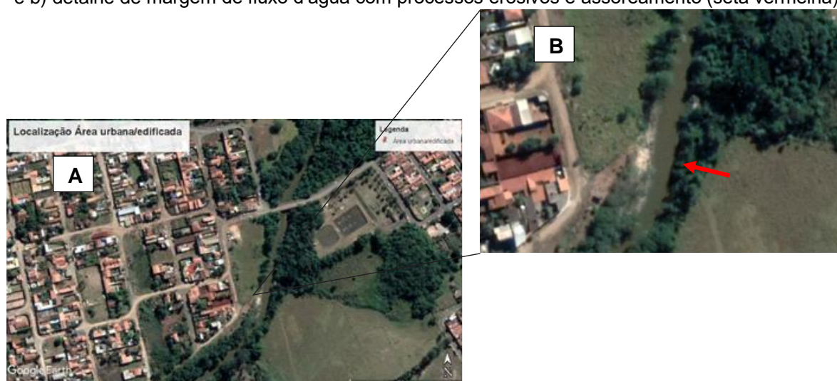
Figura 21: a) Residências ocupando área de APP descaracterizada e b) detalhe de margem de fluxo d'água com processos erosivos e assoreamento (seta vermelha)
