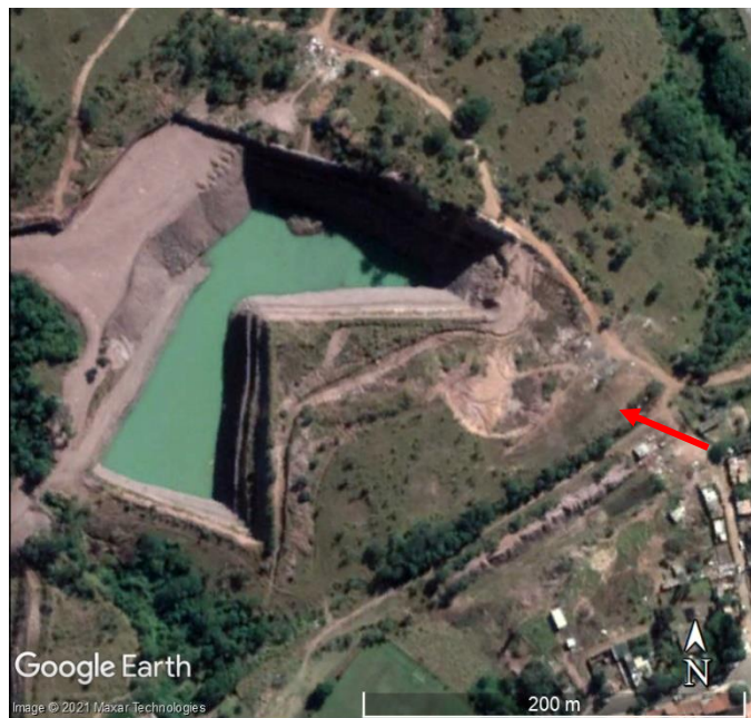
Figura 29: Ausência de cobertura vegetal e processos erosivos de formação de sulcos (seta vermelha) identificados na zona Área das cavas, Cava 2
