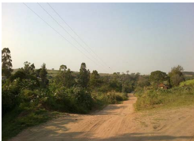
Foto 4 – Rede Elétrica e estradas
