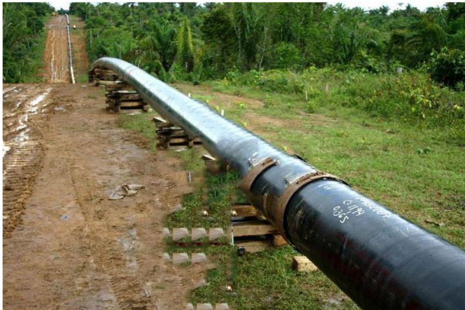
Figura 10 – Faixa de servidão construída nas extensões dos dutos.
