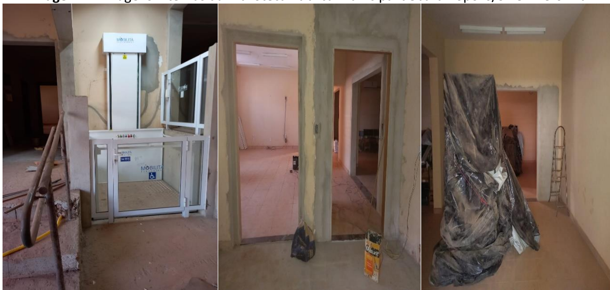
Imagem 4 - Imagens internas da Biblioteca Pública Municipal de Jardinópolis/SP em reforma.
