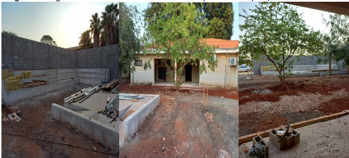
Imagem 5 - Imagens externas da Biblioteca Pública Municipal de Jardinópolis/SP em reforma.
