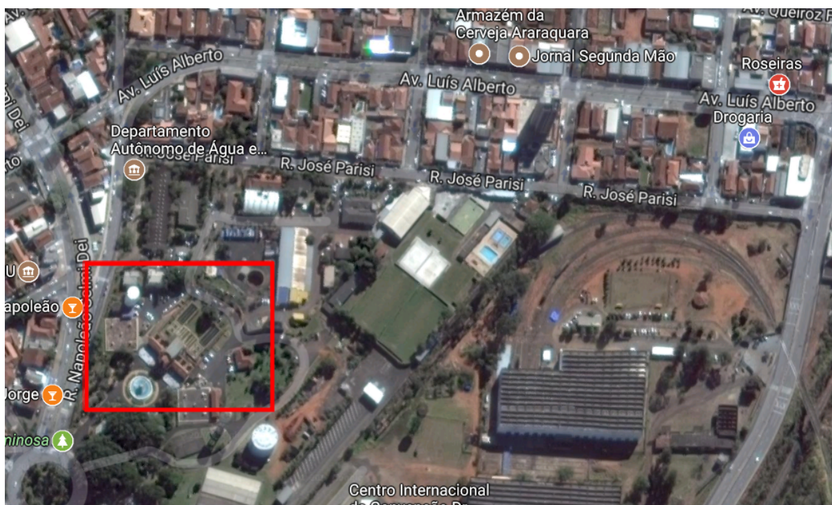
Figura 4 – Tratamento de Água do Município de Araraquara.
