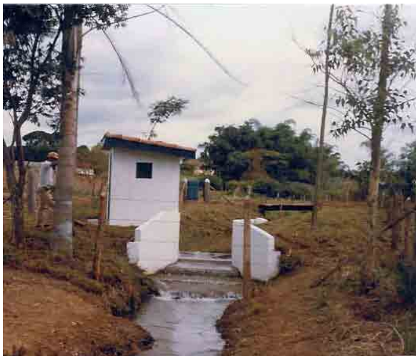
Figura 3. Estrutura de medição de descarga na microbacia do rio dos Búfalos.
