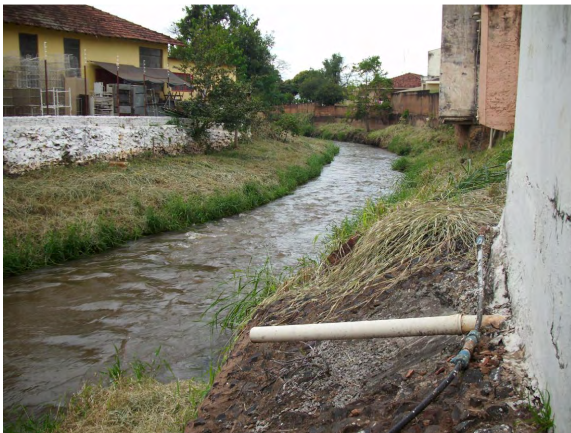
Figura 8: Áreas de Preservação Permanente ocupadas por construções nas margens do Rio Lençóis na área urbana de Lençóis Paulista. Fonte: Milena M. Mileski Maio/2.010.
