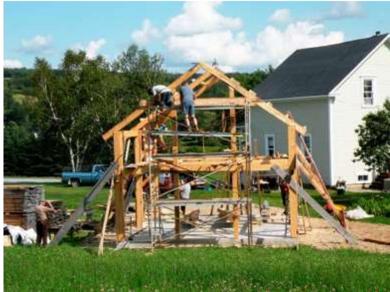
Figura 29 - Montagem do wood frame
