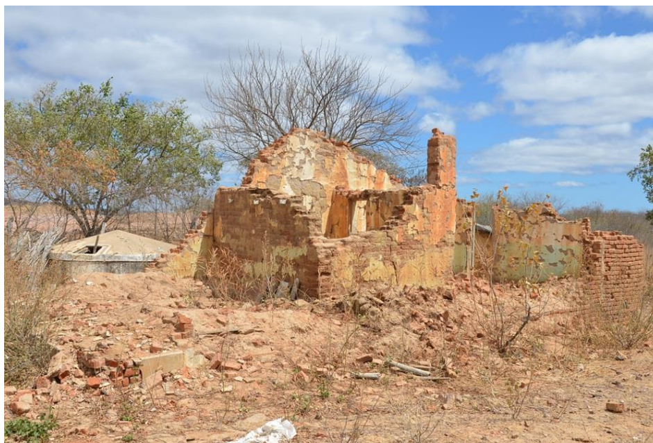
Figura 15: Residência demolida devido a construção da ferrovia Transnordestina Fonte: SOUSA, Pesquisa de campo, outubro. 2014.
