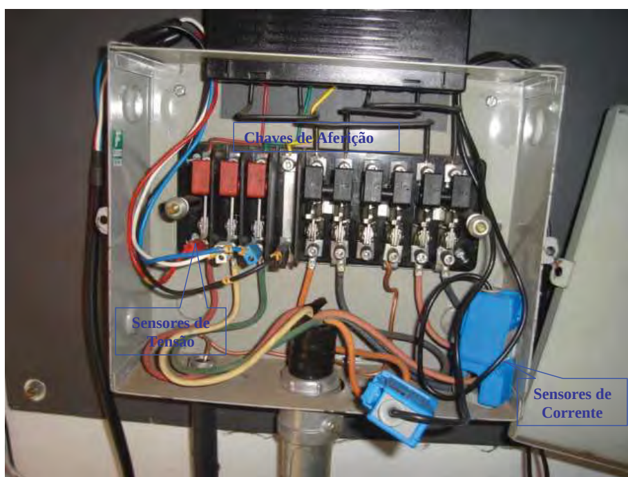
Figura 3.9. Detalhe da Conexão dos Sensores de Tensão e Corrente, nas Chaves de Aferição.
