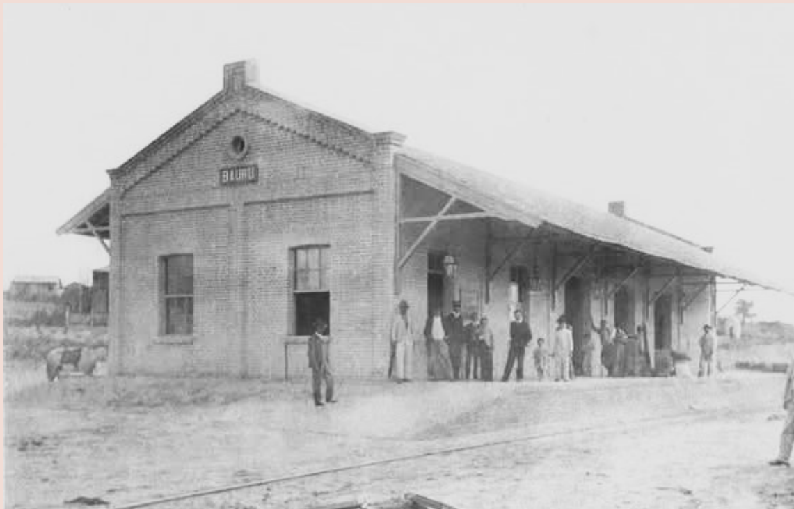
Figura 6: Estação Ferroviária da Companhia Estrada de Ferro Sorocabana.
