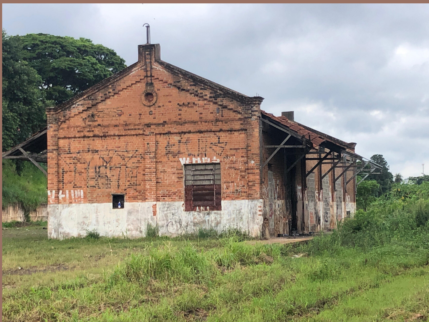
Figura 28: Estação da antiga EFS.
