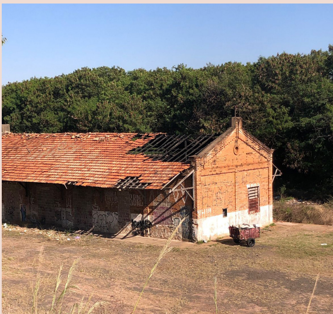
Figura 14: Frente e lateral da Estação.
