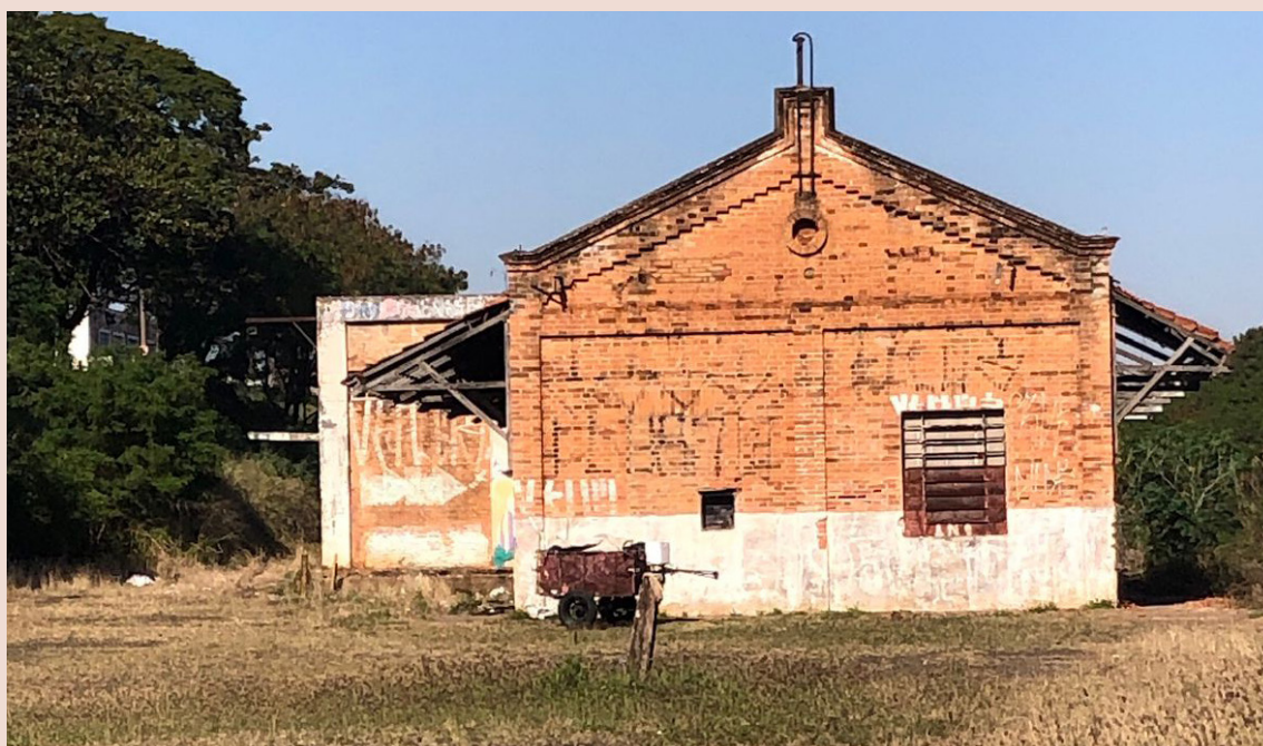
Figura 12: Ao fundo, a parede do antigo galpão de depósito geminada a estrutura da Estação.
