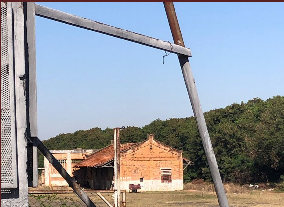
Figura 23: Vegetação arbórea próximo a antiga Estação da EFS.
