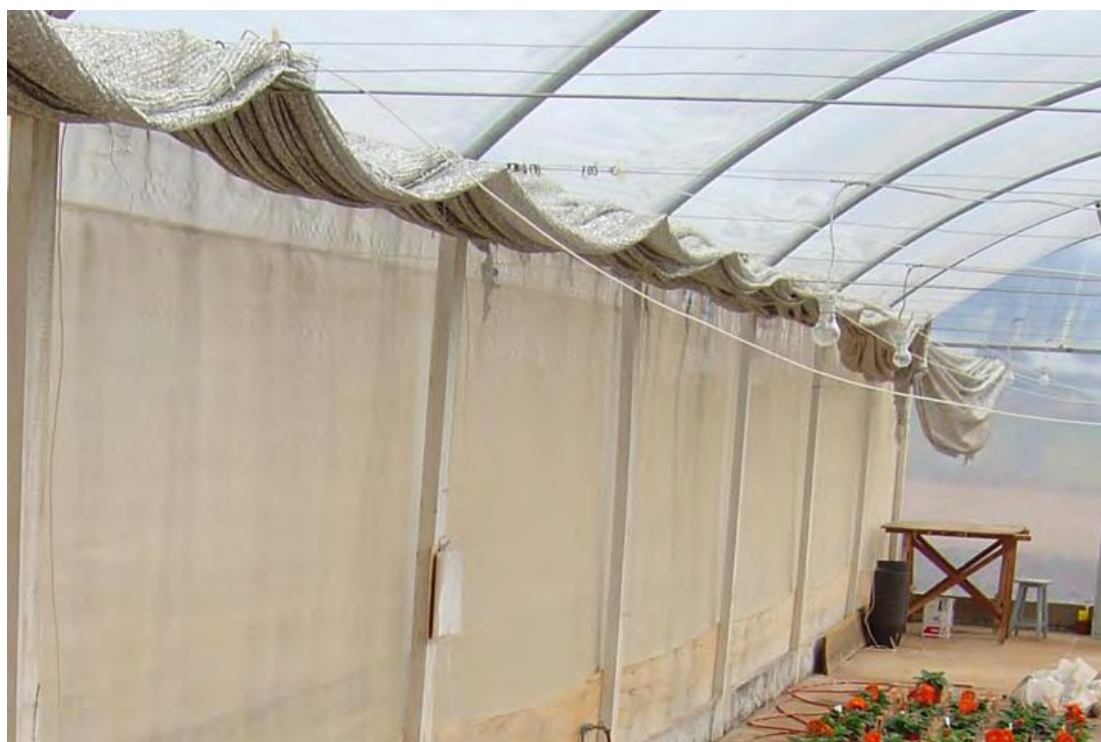
Figura 1. Vista geral da estrutura da estufa e sistema de malha termorefletora. Botucatu, SP. 2006.
