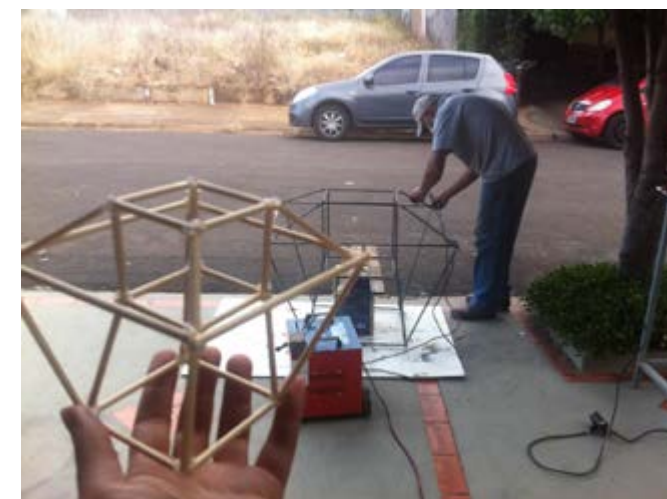
Figuras 32, 33 e 34: Montagem das estruturas
