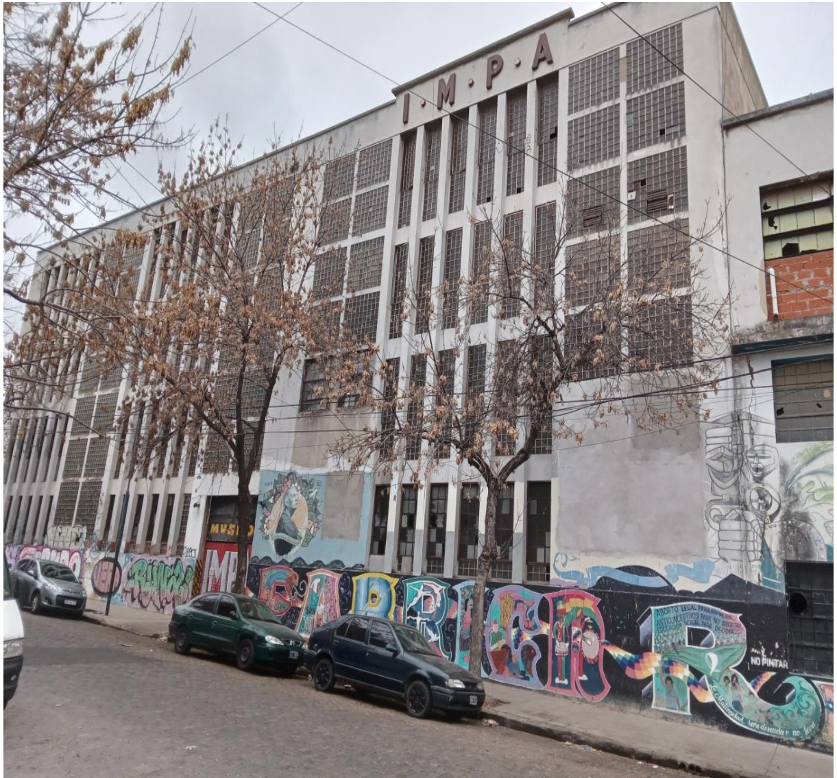
Figura 9: Extensão da fábrica IMPA vista de Querandíes
