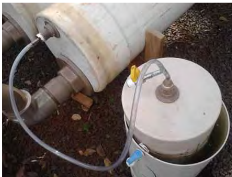
Figura 6. Sistema de abastecimento de gás do biodigestor para o gasômetro.
