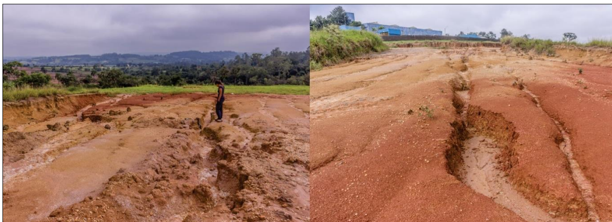
Figura 13 - Sulcos e ravinas produtos do processo erosivo instalado na localidade.
