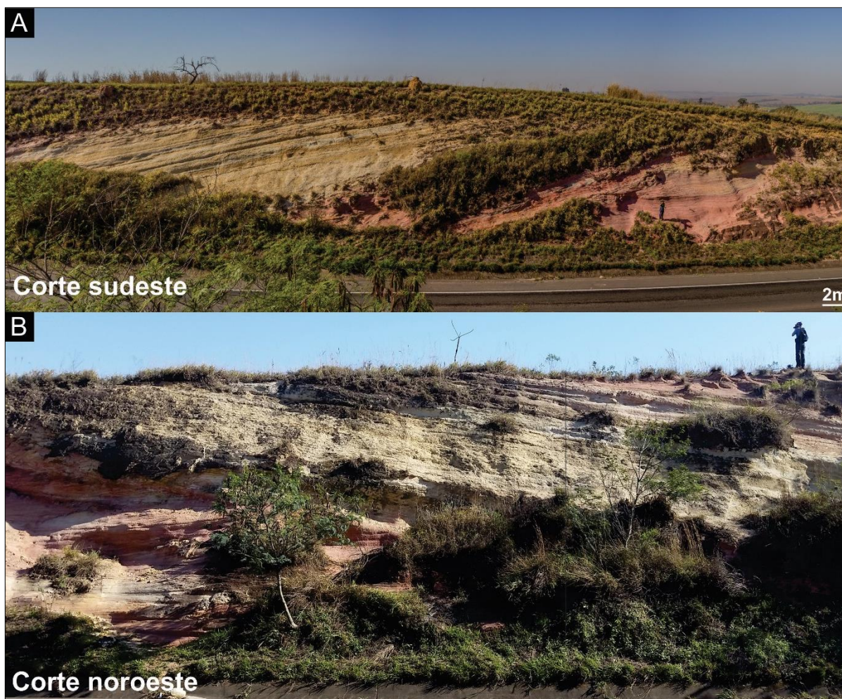
Figura 15 - Afloramento nas margens da rodovia exibindo os arenitos e estratificações cruzadas da Formação Piramboia.
