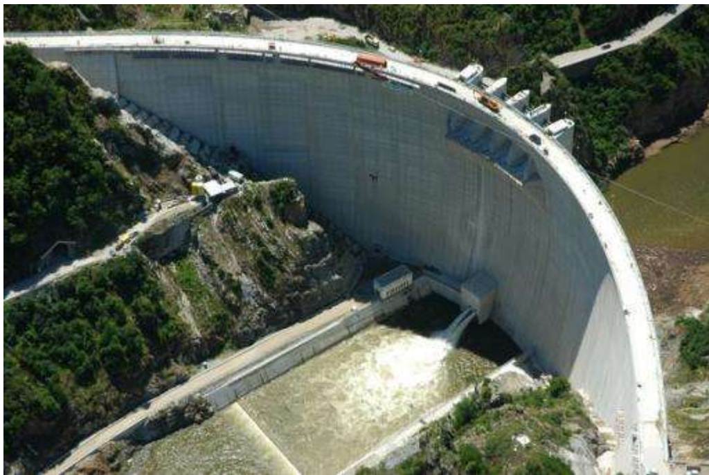
Figura 6 - Barragem da usina hidrelétrica de Tsankov Kamak, na Bulgária.
