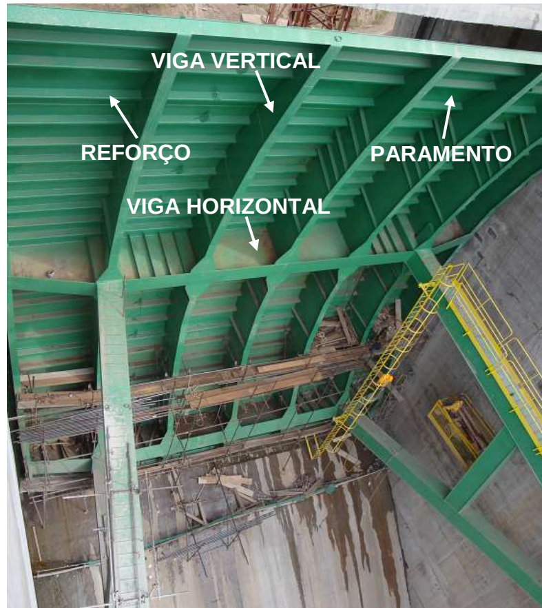
Figura 18 - Paramento de uma comporta radial.
