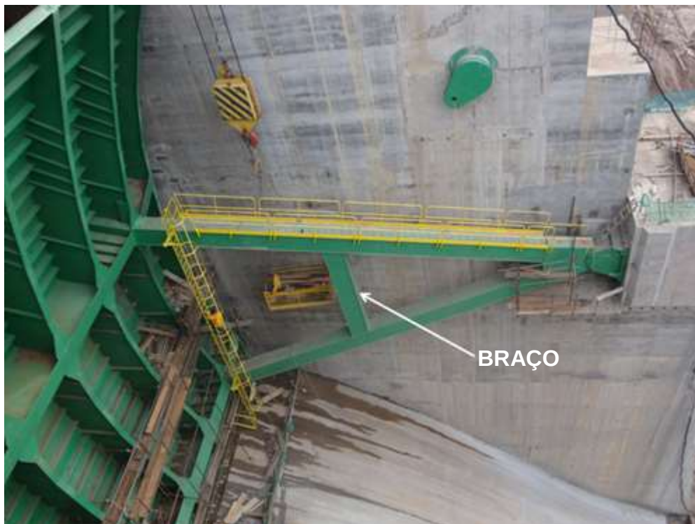
Figura 24 - Conjunto do braço de uma comporta radial.
