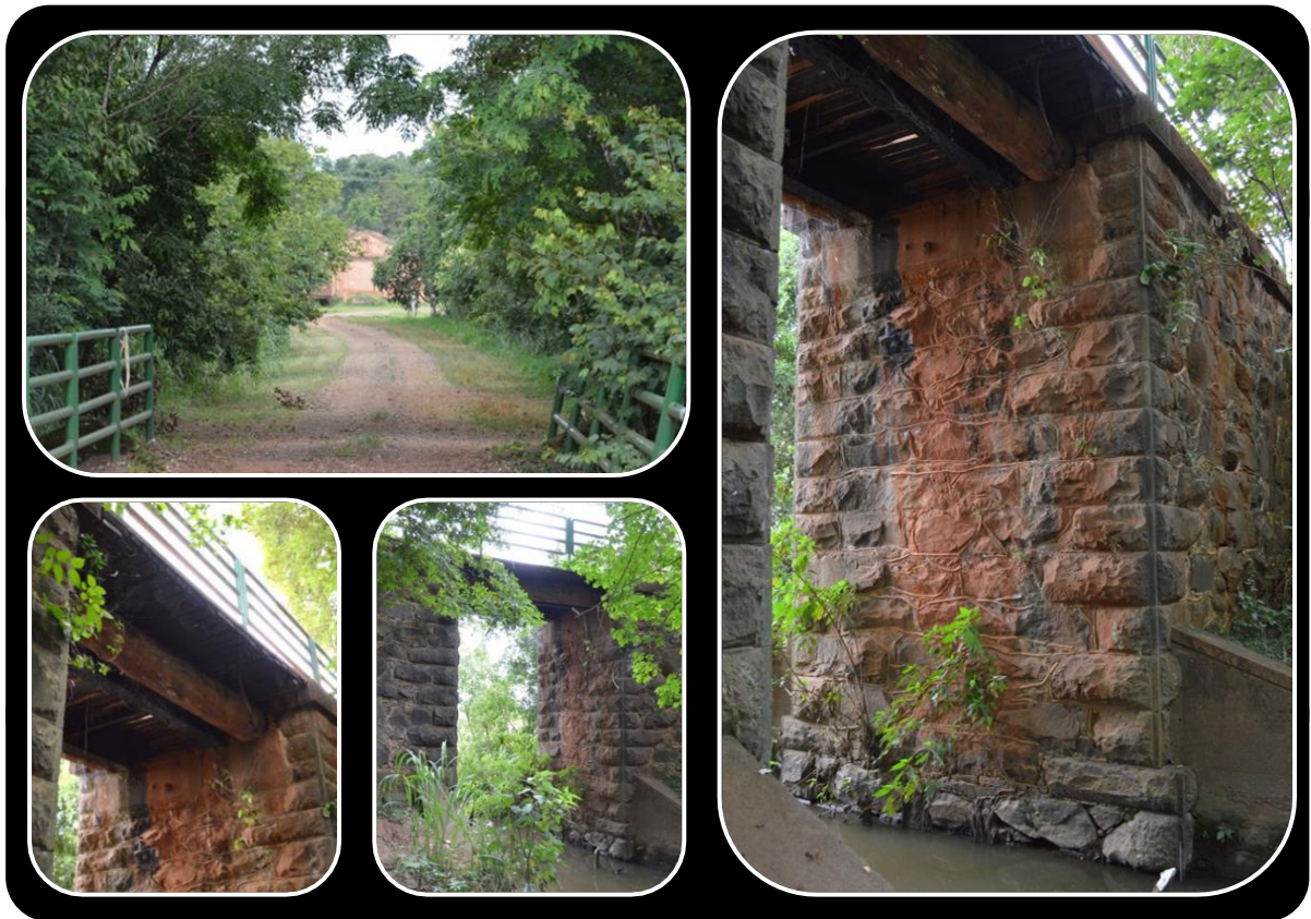
Figura 11: Mosaico de fotos de uma antiga ponte do ramal de Descalvado (à esquerda acima: foto sobre a ponte visualizando o antigo traçado dos trilhos; à esquerda abaixo: estrutura de ferro e madeira abaixo da ponte; ao centro abaixo: ponte vista do nível do córrego; e, à direita, estrutura de pedras da ponte).
