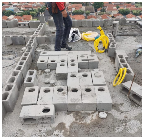
Figura 38 – Cortes nos blocos para caixas elétricas
