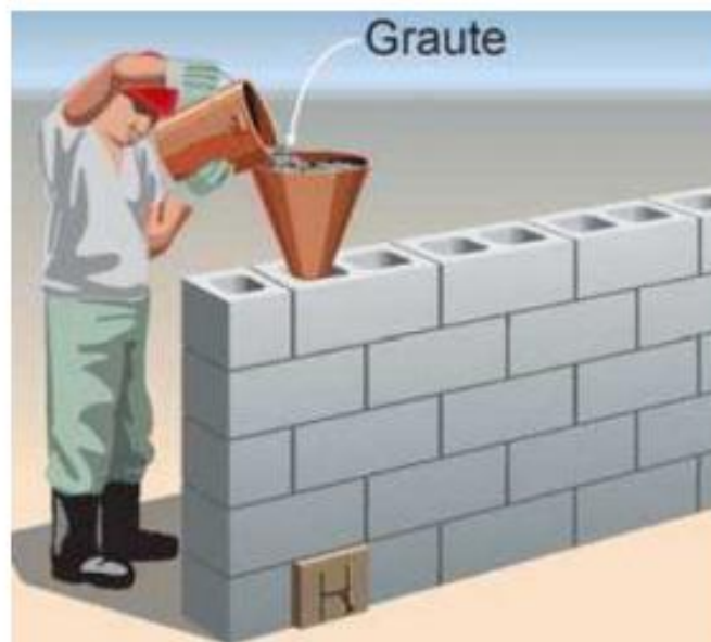
Figura 8 – Preenchimento de graute no vazio do bloco
