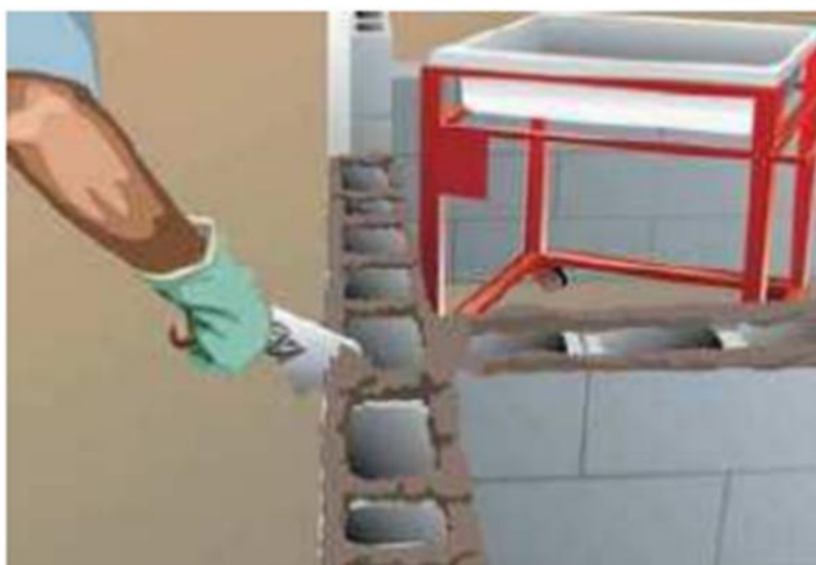
Figura 7 – Argamassa assentada em blocos de concreto
