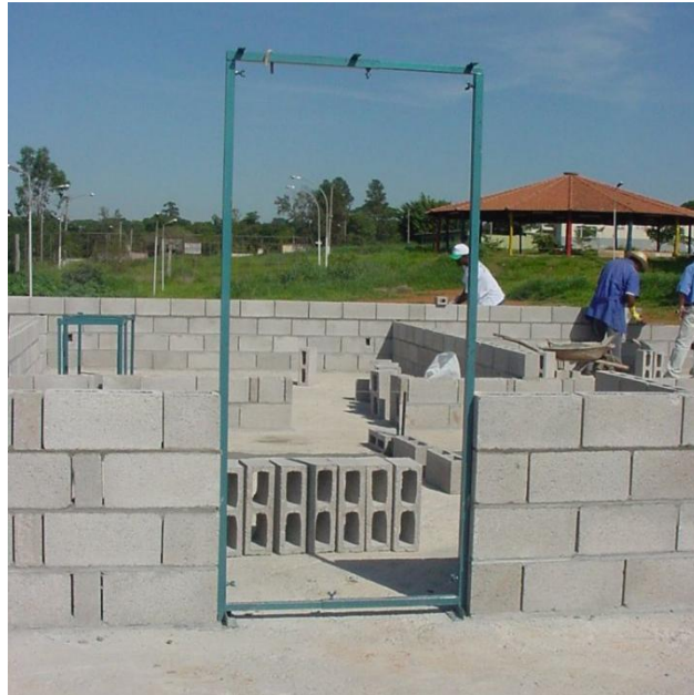
Figura 20 – Gabaritos de portas e janelas
