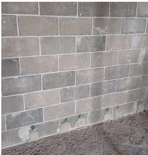
Figura 40 – Pontos de graute marcados na primeira fiada
