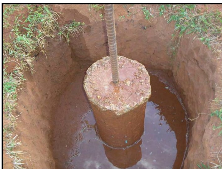
Figura 6.7: Lâmina d'água na superfície do bloco de solo-cimento para garantir cura adequada.
