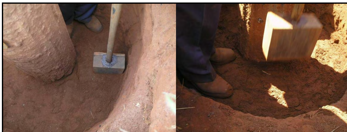
Figura 6.5: Compactação de camada intermediária do bloco de solo-cimento.
