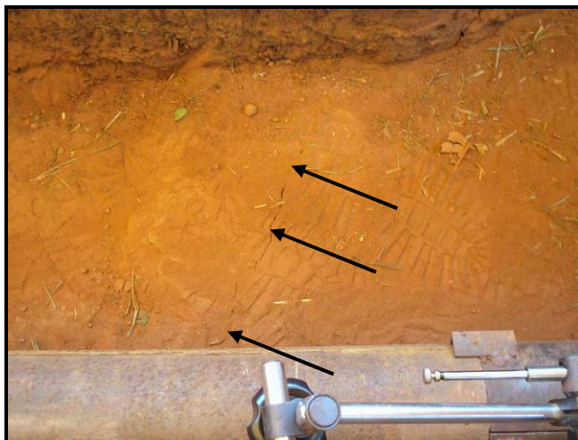
Figura 7.8: Primeira trinca notada na interface do bloco com o solo natural (11° estágio de carregamento, carga de 44 kN, 34% da carga máxima aplicada, y_t=2,89 mm).
