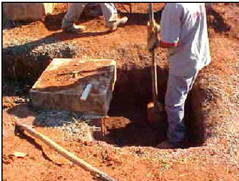
Figura 2.17: Processo de execução do bloco de solo-cimento compactado (MIRANDA Jr., 2006).
