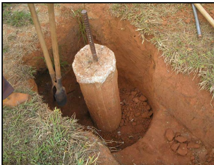
Figura 6.3: Execução da escavação onde foi compactado o solo-cimento.
