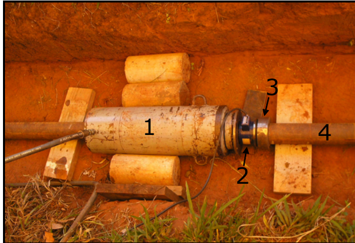
Figura 6.10: Sistema de aplicação, aferição e transferência da carga aplicada nas estacas.
