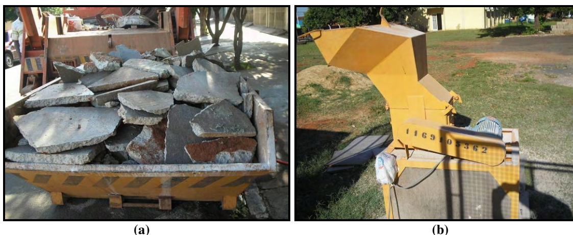
Figura 5.3: Resíduo de concreto em fase de início de transporte (a) e triturador utilizado para beneficiamento do resíduo (b).
