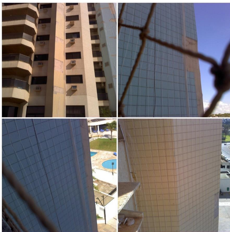
Figura 20. Detalhes das telas de proteção colocadas nos edifícios.
