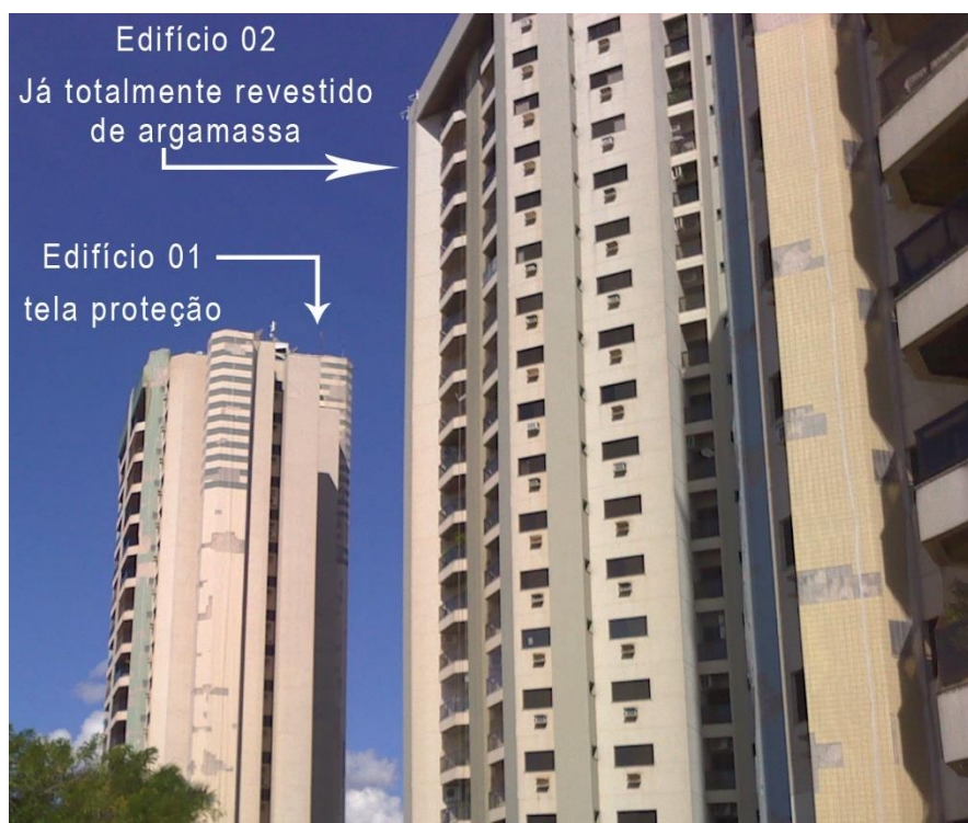
Figura 19. Situação das fachadas dos edifícios em julho de 2017.
