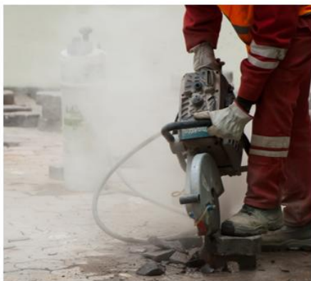
Corte de pedra de calçada em Paris.
