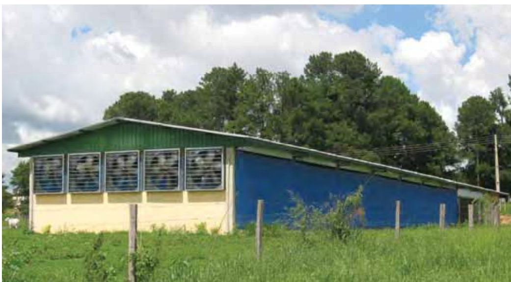
Foto 5 - Galpão climatizado utilizado para criação dos frangos.
