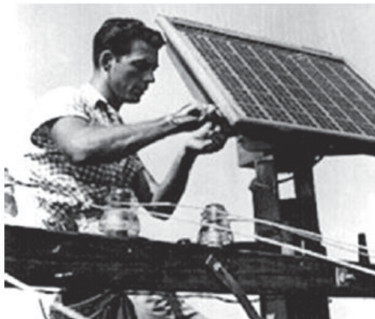
Figura 2.5: Painel solar com a tecnologia de Fuller. Aplicação na rede de telefonia de Americus, Georgia, EUA em 1955. (PARTEIN, 1995)
