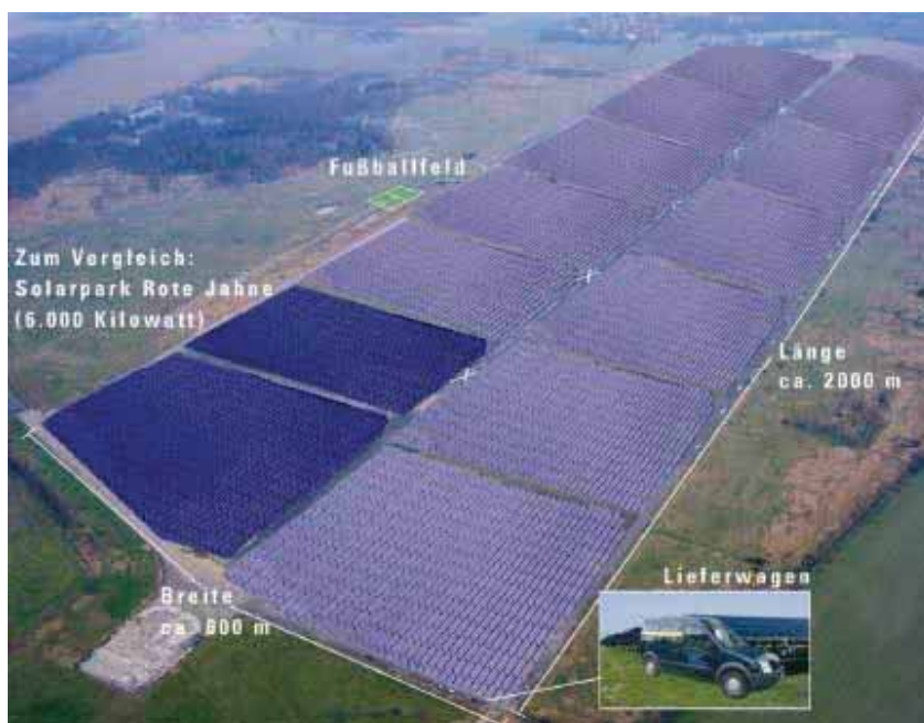
Figura 3.2: Complexo Waldpolenz, Brandis, Alemanha. A capacidade instalada na ocasião da foto é de 6MW. (Energias Renováveis,2009)
