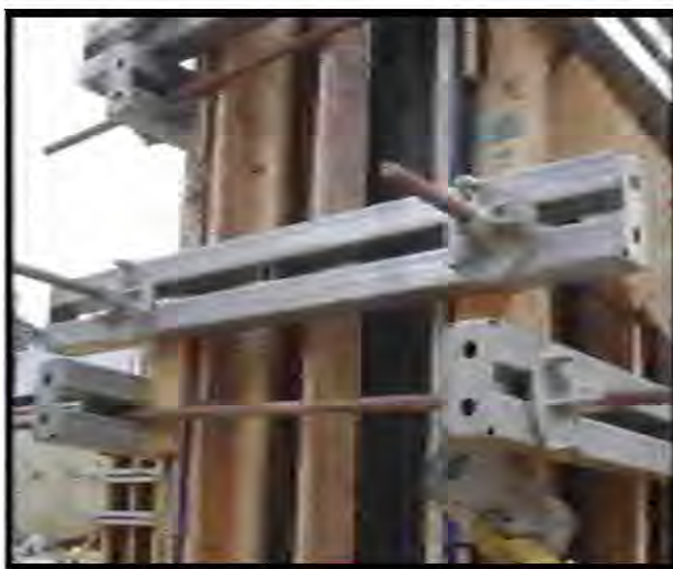
Figura 4 – Barra ancoragem, porca borboleta e sanduíche metálico (Fonte: Especificações Técnicas Gafisa – Cimbramento, pág. 3)
