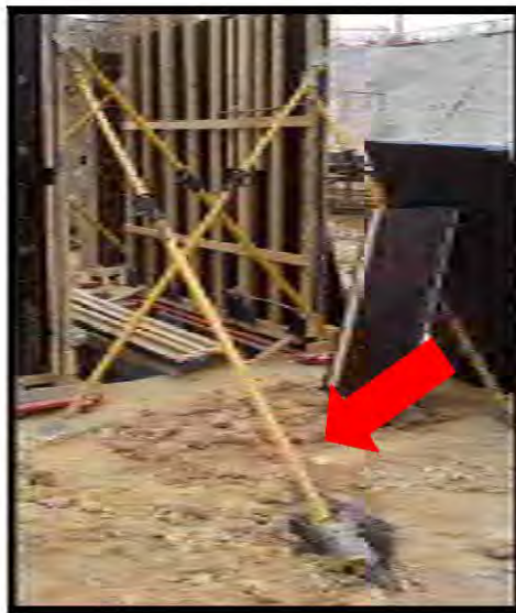
Figura 8 – Aprumador metálico com regulagem milimétrica (Fonte: Especificações Técnicas Gafisa – Cimbramento, pág. 3)
