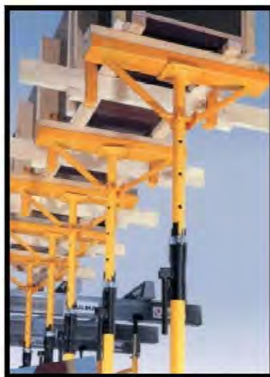
Figura 13 – Escora com cruzeta para apoio da viga (Fonte: KJP Andaimos e Máquinas.
