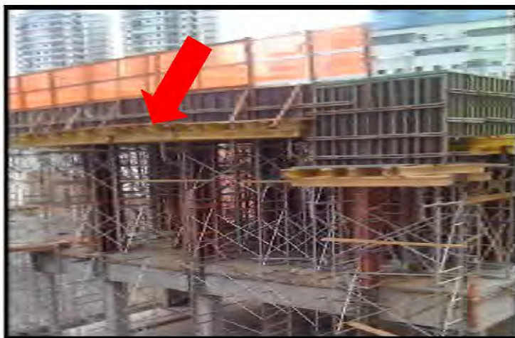
Figura 11 – Torres metálicas para o cimbramento das vigas
