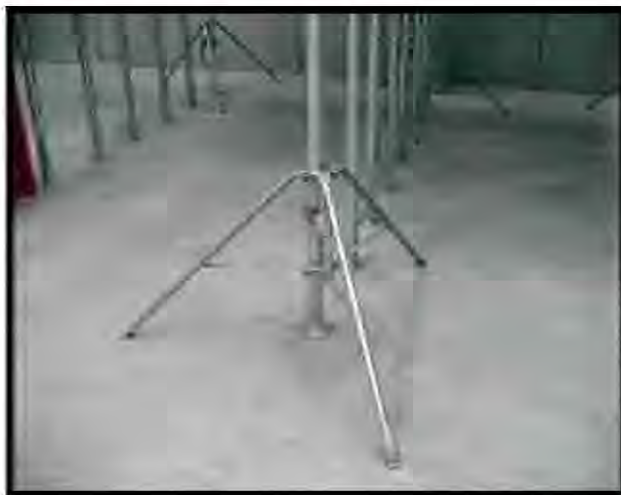
Figura 14 – Escora metálica com tripé (Fonte: Via Trade Escoras Metálicas. Disponível em: http://www.escorasmetalicas.com.br/acessorios.cfm )
