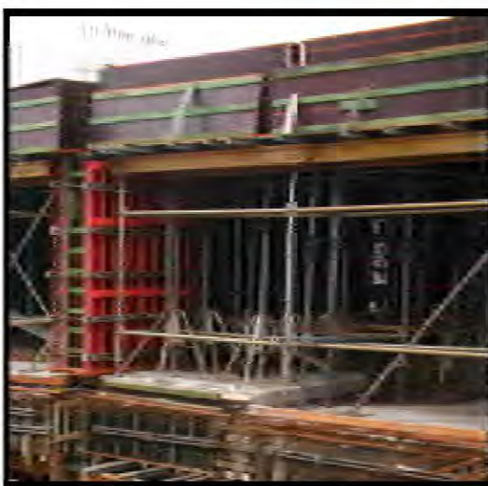
Figura 17 – Cimbramento da laje
