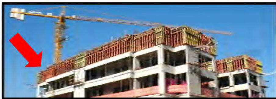
Figura 12 – Escoras de madeira para o cimbramento de vigas
