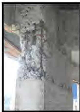
Figura 31 – “Bicheiras” (Fonte: Especificações Técnicas Gafisa – Estrutura concreto armado, pág. 9)
