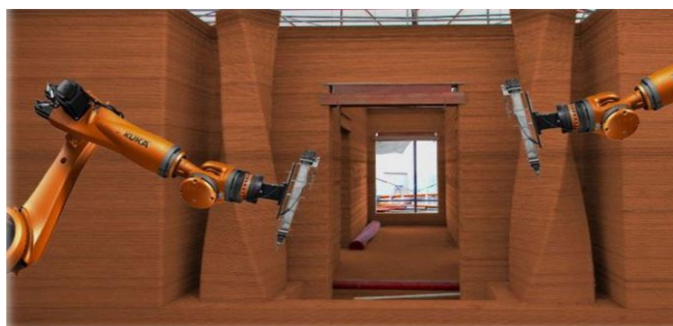
Figura 13- Impressora 3D e a casa feita com terra
