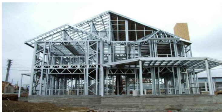
Figura 11 – Casa em Light Steel Frame
