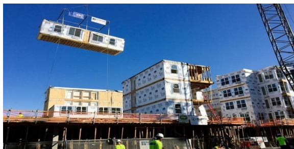
Figura 8- Montagem em obra.
