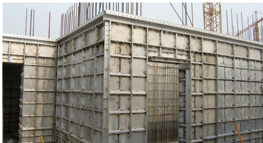
Figura 5 – Formas para parede de concreto moldada in loco
