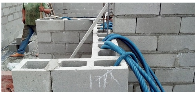
Figura 10 – Passagem de tubulações através da parede em alvenaria estrutural
