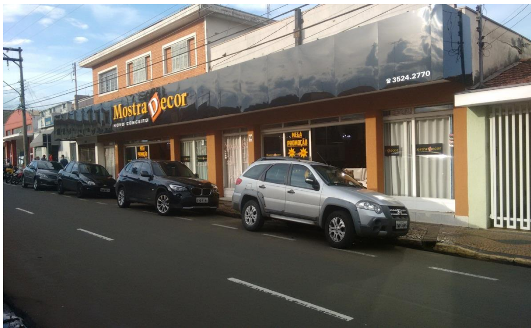
Figura 7 - Fachada atual do comércio Móveis Santana
