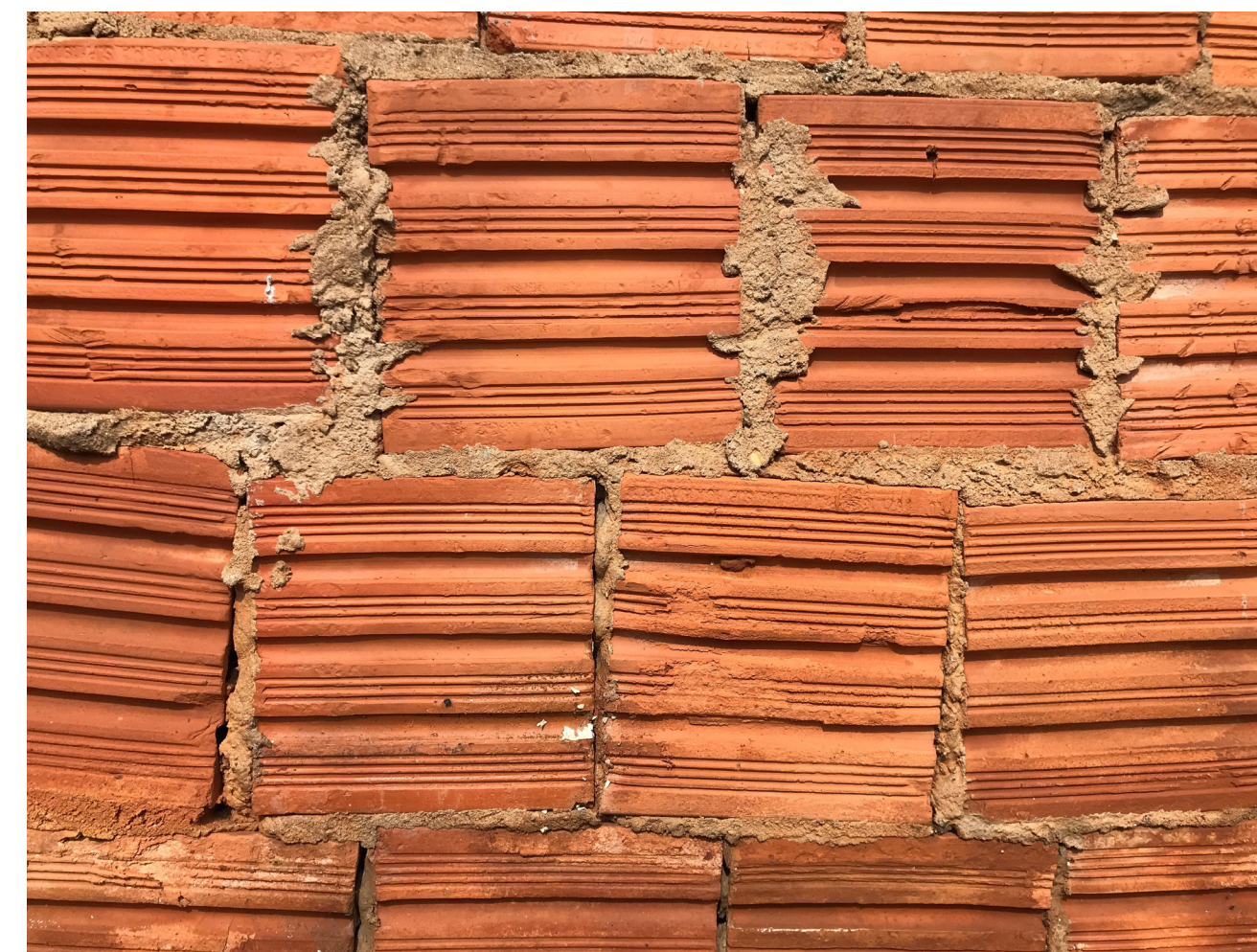
IMAGEM 32: parede tijolos original, 2018, acervo pessoal
