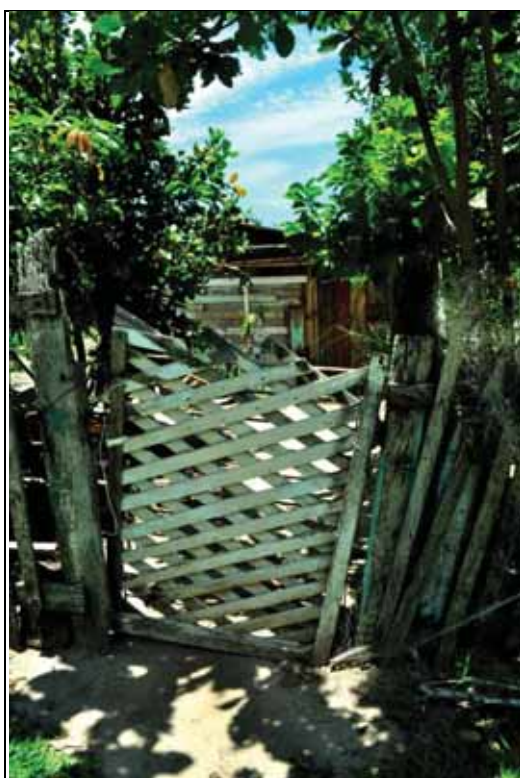
Foto 3 - Acampamento Lagoinha Barraco cercado e com portão.
