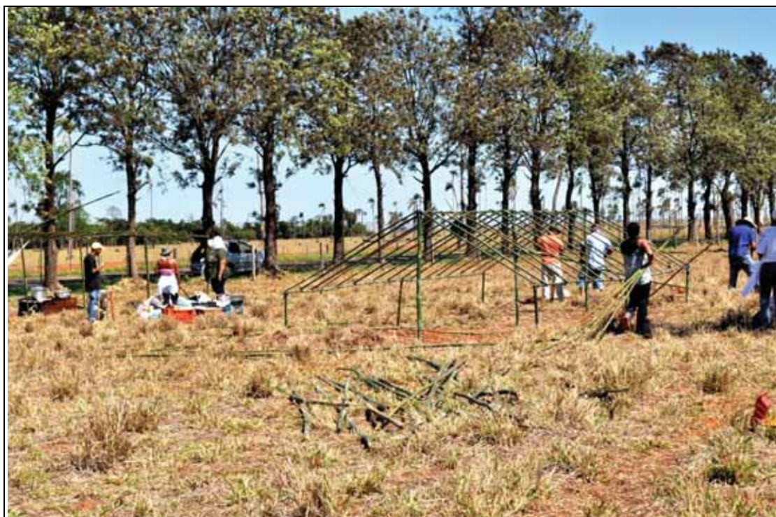
Foto 25 - Ocupação da fazenda Nazaré - Construção dos barracos
