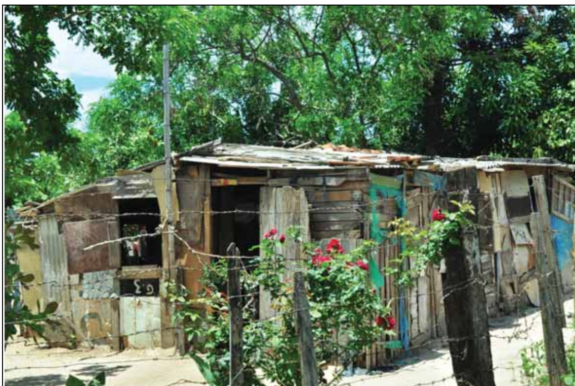
Foto 2 - Acampamento Lagoinha - Barraco de madeira cercado.
