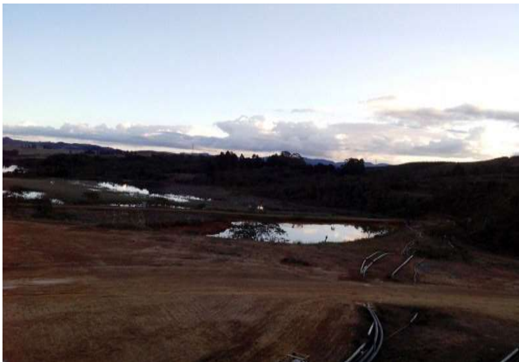
Figura 12. Foto das Bacias de Decantação após o tratamento para neutralização das águas ácidas.
