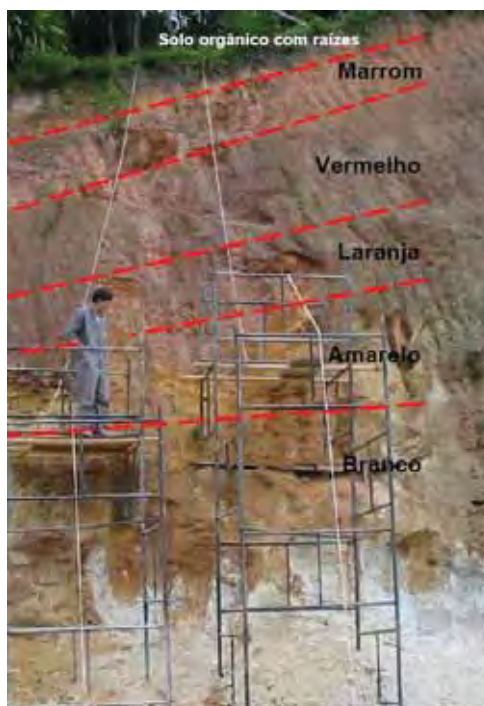
Figura 3.22 - Vista geral do talude e divisăo das camadas (BOSZCZOWSKI, 2008)
