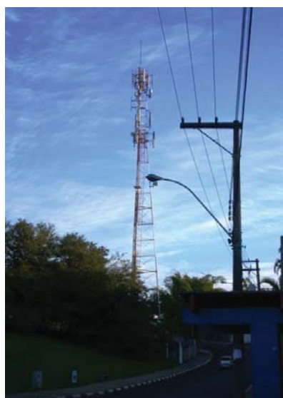
Figura 153 – Estação Rádio Base 49
