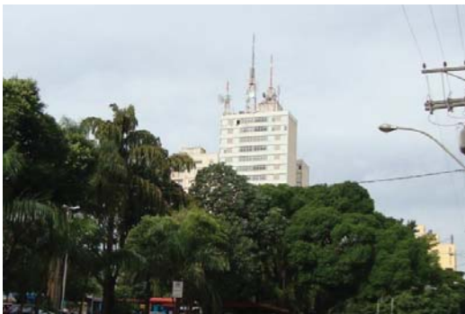
Figura 128 – Estação Rádio Base 40
