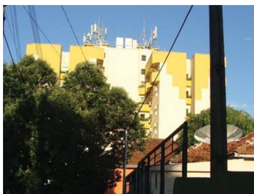
Figura 144 – Estação Rádio Base 46
