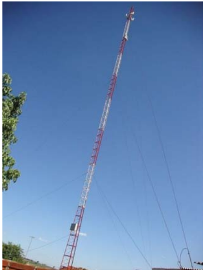
Figura 105 – Estação Rádio Base 32
