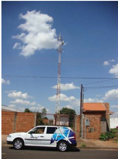
Figura 40 – Estação Rádio Base 9
