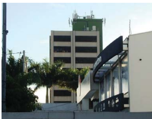
Figura 150 – Estação Rádio Base 48
