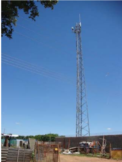
Figura 74 – Estação Rádio Base 21
