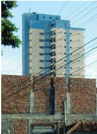
Figura 138 – Estação Rádio Base 44
