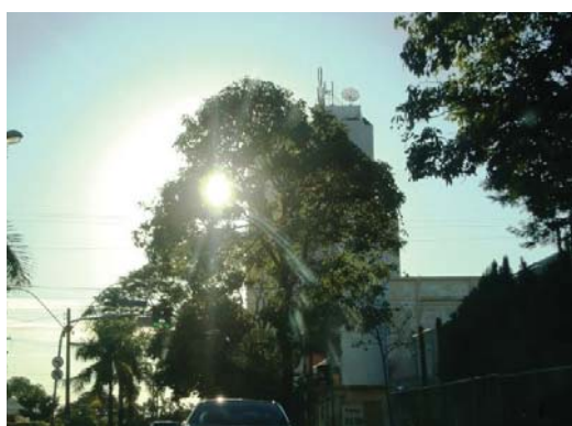
Figura 147 – Estação Rádio Base 47
