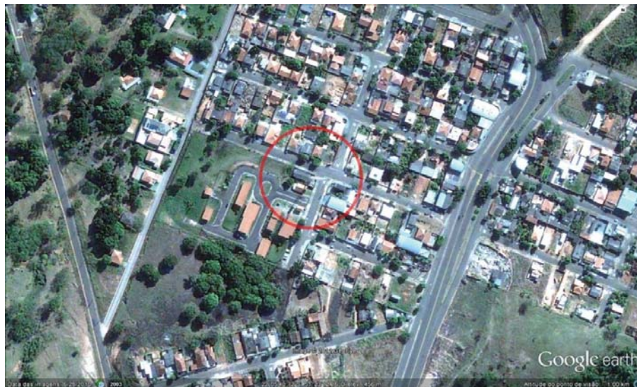
Figura 21 – Localização e área de risco da Estação Rádio Base 3 FONTE: Google Earth
