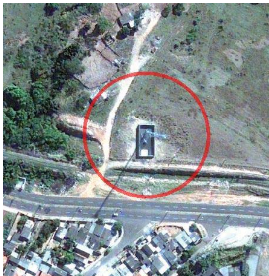
Figura 29 – Área de risco da ERB 5 FONTE: Google Earth
