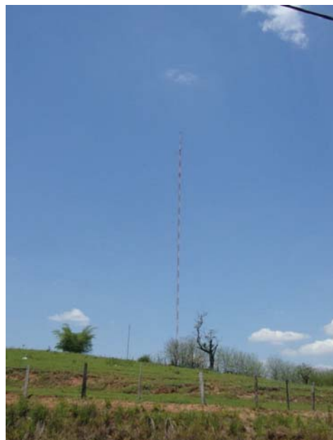
Figura 16 - Estação Rádio Base 2
