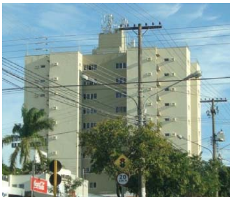
Figura 135 – Estação Rádio Base 43
