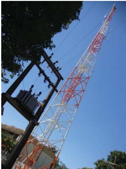
Figura 89 – Estação Rádio Base 26
