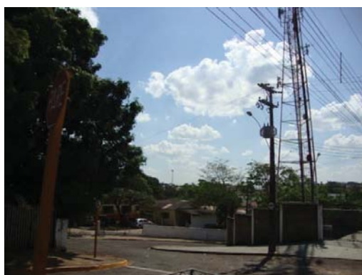
Figura 53 – Estação Rádio Base 13
