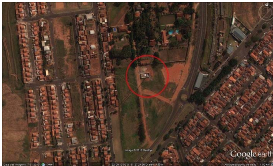
Figura 76 – Localização e área de risco da Estação Rádio Base 21
