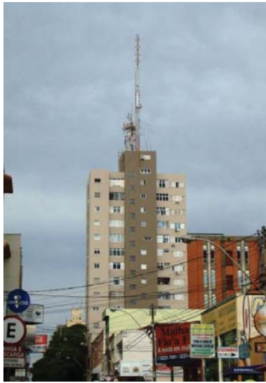
Figura 130 – Estação Rádio Base 41
