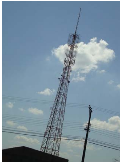
Figura 38 – Estação Rádio Base 8
