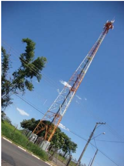
Figura 68 – Estação Rádio Base 18
