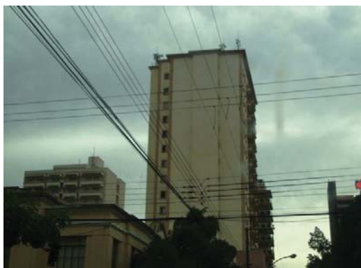
Figura 124 – Estação Rádio Base 38
