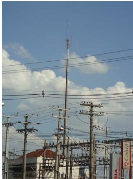
Figura 57 – Estação Rádio Base 14
