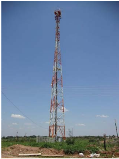
Figura 12 - Estação Rádio Base 1
