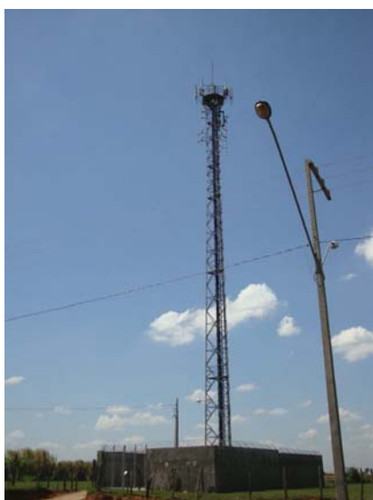
Figura 34 – Estação Rádio Base 7
