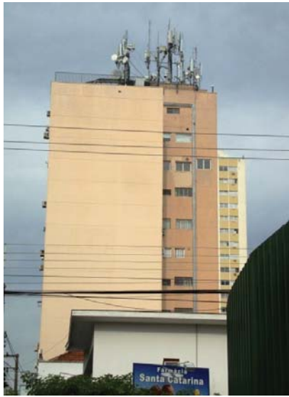
Figura 126 – Estação Rádio Base 39
