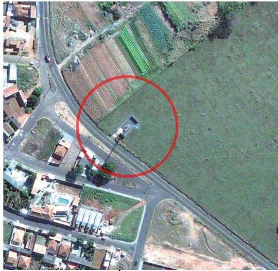
Figura 36 – Área de risco da ERB 7 FONTE: Google Earth
