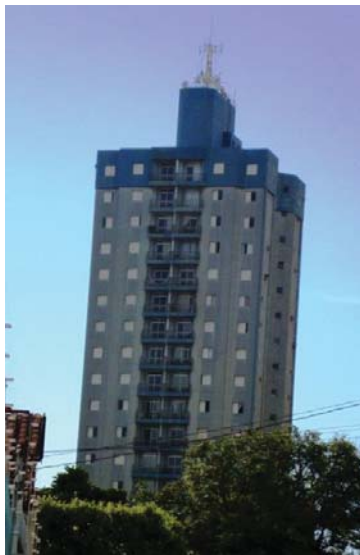
Figura 132 – Estação Rádio Base 42
