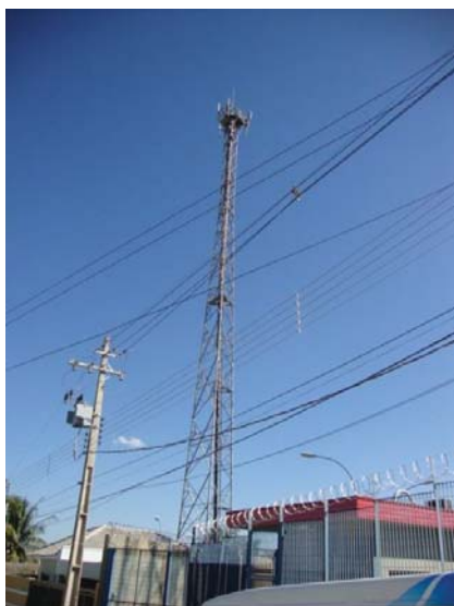
Figura 111 – Estação Rádio Base 34
