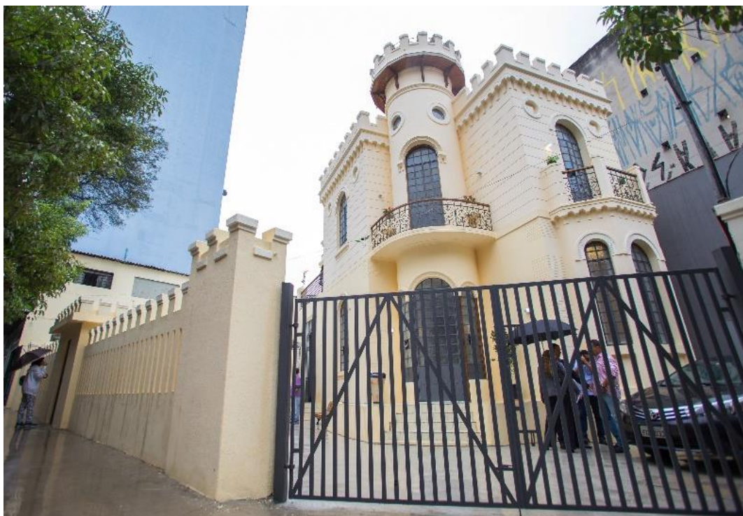
Figura 5: Castelinho da Rua Apa
