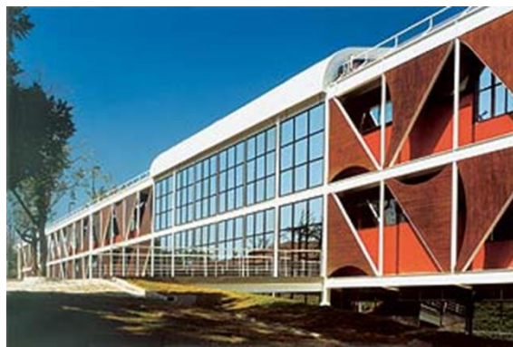
Figura 21: Fachada Sul. Fonte: Nelson Kon (ArcoWeb), 2014.
