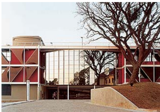
Figura 20: Fachada Norte. Fonte: Nelson Kon (ArcoWeb), 2014.
