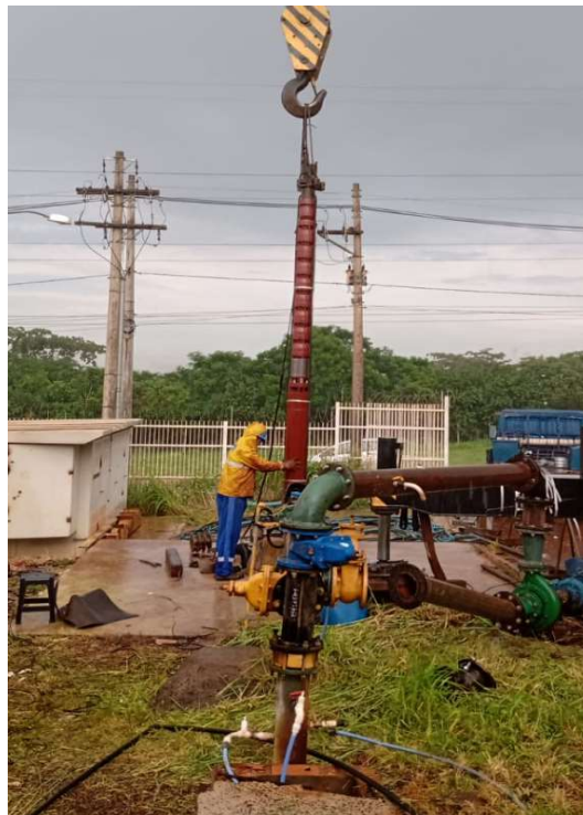
Figura 2 - Instalação de conjunto motobomba submersa elétrica para poço.
