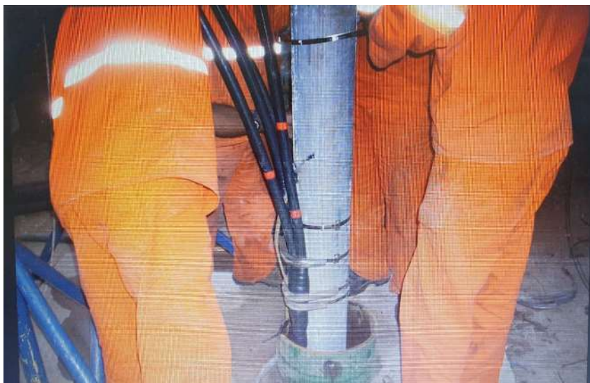
Figura 7 – Introdução de Cabos Elétricos na instalação do CMSEP.
