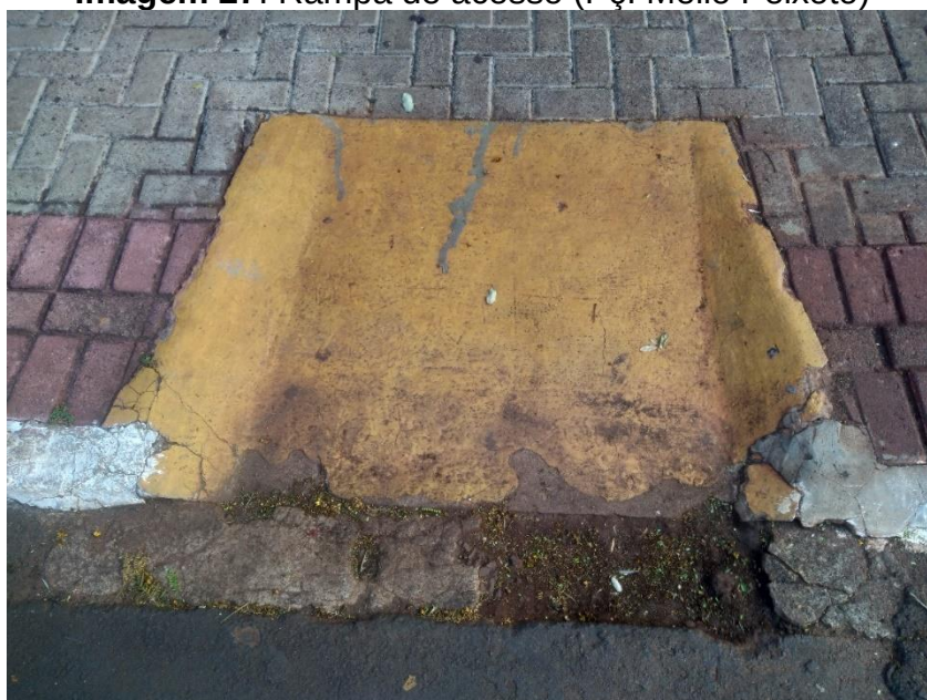
Imagem 27: Rampa de acesso (Pç. Mello Peixoto)
