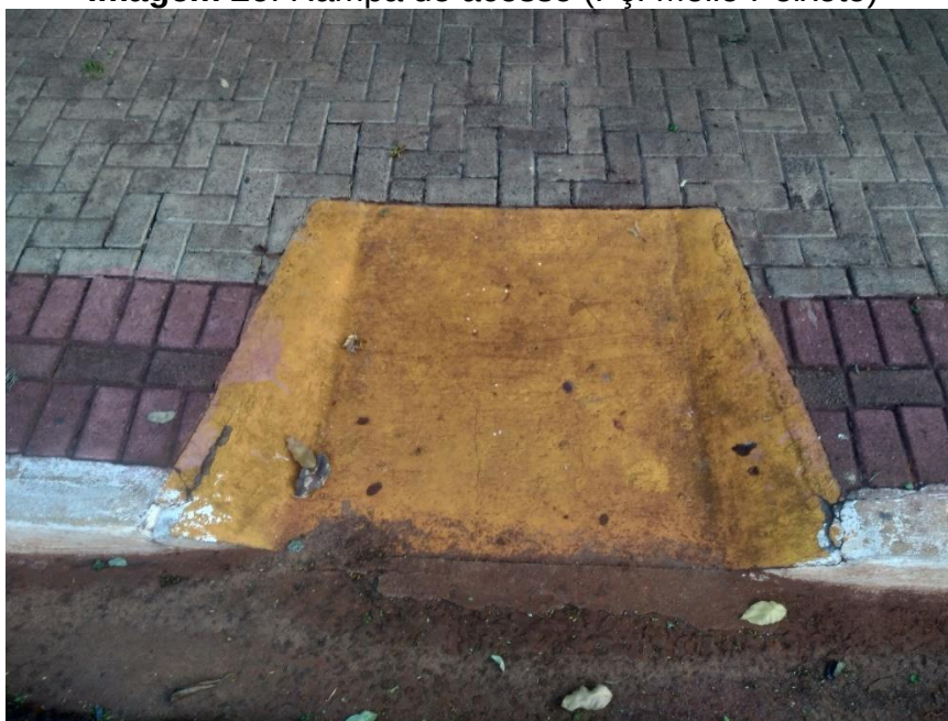
Imagem 26: Rampa de acesso (Pç. Mello Peixoto)
