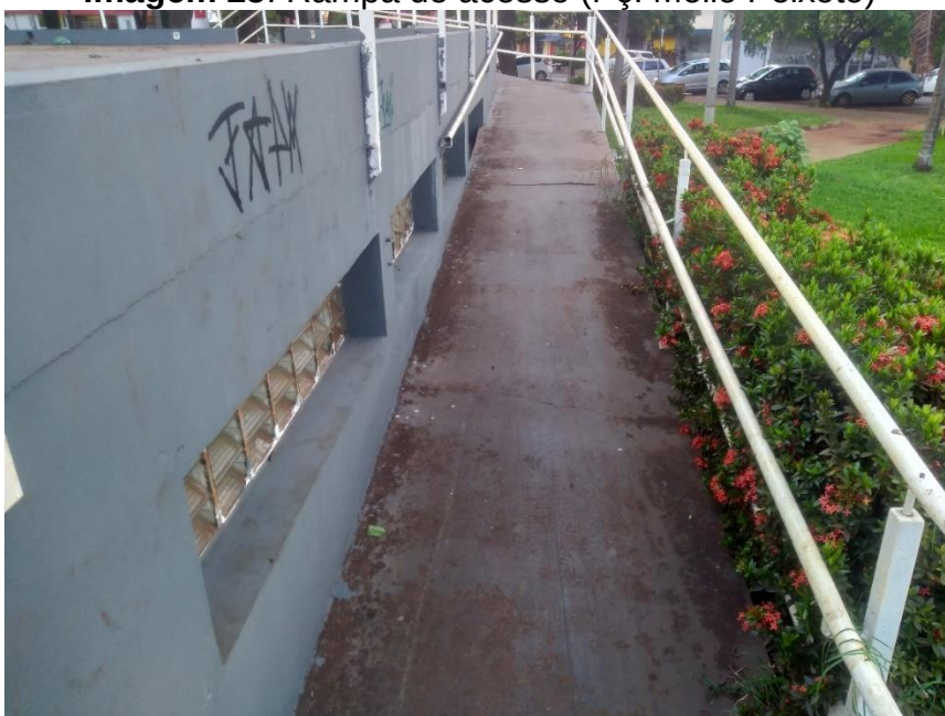
Imagem 25: Rampa de acesso (Pç. Mello Peixoto)
