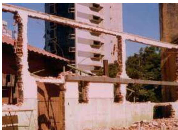
Ilustração 3: Exemplo de demolição seletiva (Fonte: JOHN, 2005)
