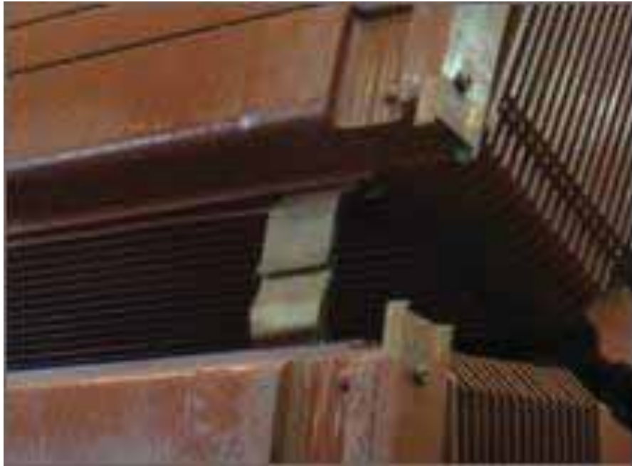
Figura 4: Foto da interligação dos Pólos.
