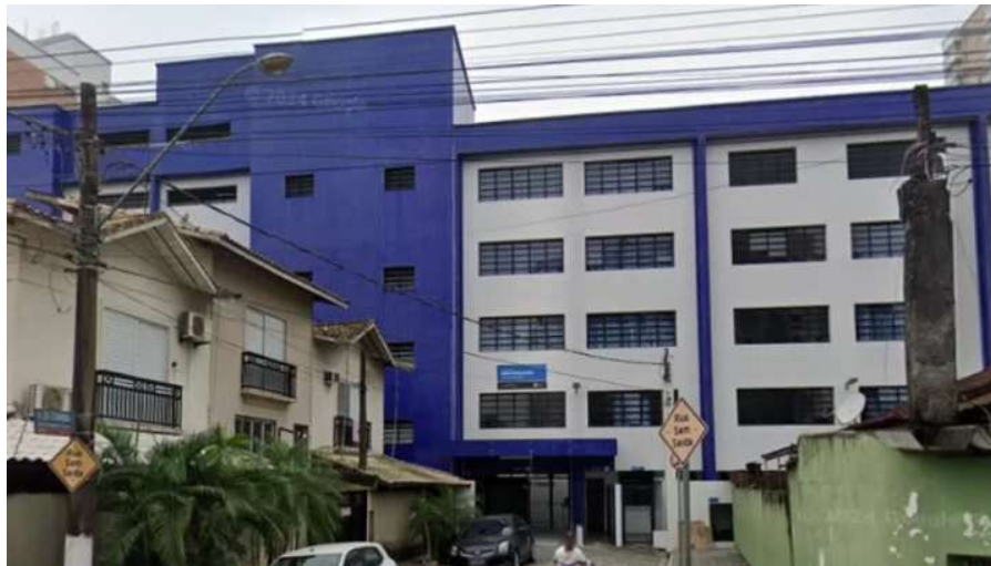
Figura 4 - Vista da entrada da E.M. João Gonçalves
