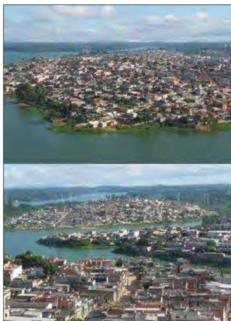
Figura 14. Ocupação próxima à barragem da represa Guarapiranga. Fonte: ( www.favelization.com/2009/04/dos-anos-70 ).
