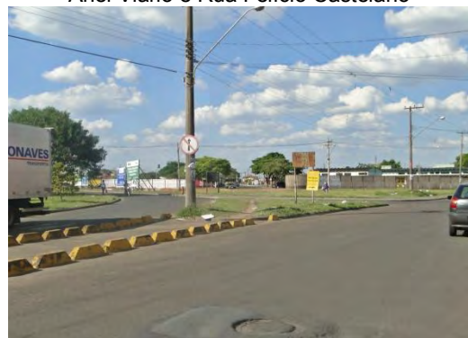
Figura 9: Rotatória da Avenida dos Estudantes, Anel Viário e Rua Felício Castelano
