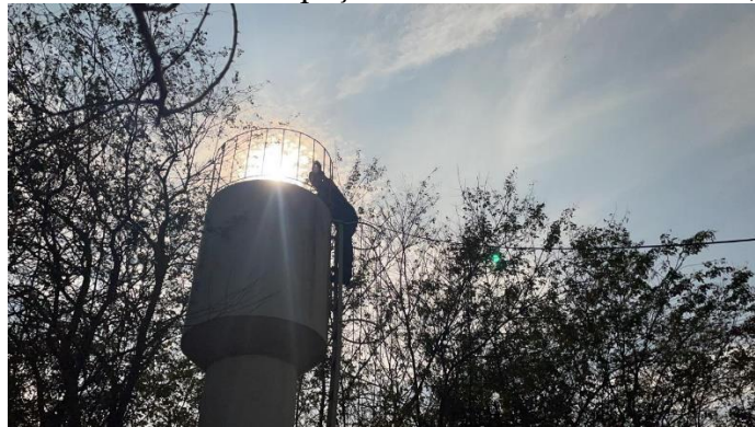
Figura 10 – Reservatório do poço Assentamento Santa Lucia, lote 16.
