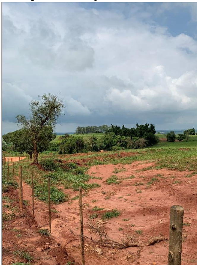
Figura 18 - Solo Exposto na área da bacia.
