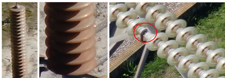
Figura 32 - Destaques da inspeção visual realizada nas cadeias de isoladores da LT
