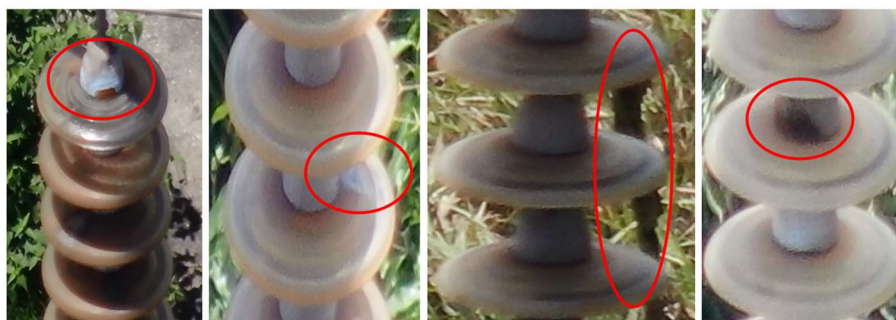
Figura 31 - Destaques da inspeção visual realizada nas cadeias de isoladores da LT
